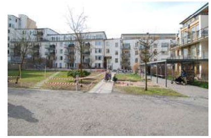
Figura 8 La corte interna al blocco aperto. Foto personale
