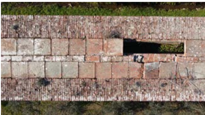
Figura 6: Lucca, Acquedotto del Nottolini, Dettaglio della copertura in prossimità del Tempietto di Guamo, 2023.
