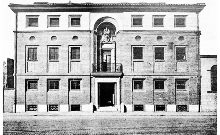
Scuola Pontificia dei Fratelli di Nostra Signora della Misericordia in Roma, Fosse di Castel Sant'Angelo, architetto Alberto Calza Bini, architetto Mario De Renzi, 1932, fotografia del prospetto principale. Credits: "L'Architettura Italiana. Periodico mensile di Costruzione e di Architettura pratica", n. 9, settembre 1932, p. 106
