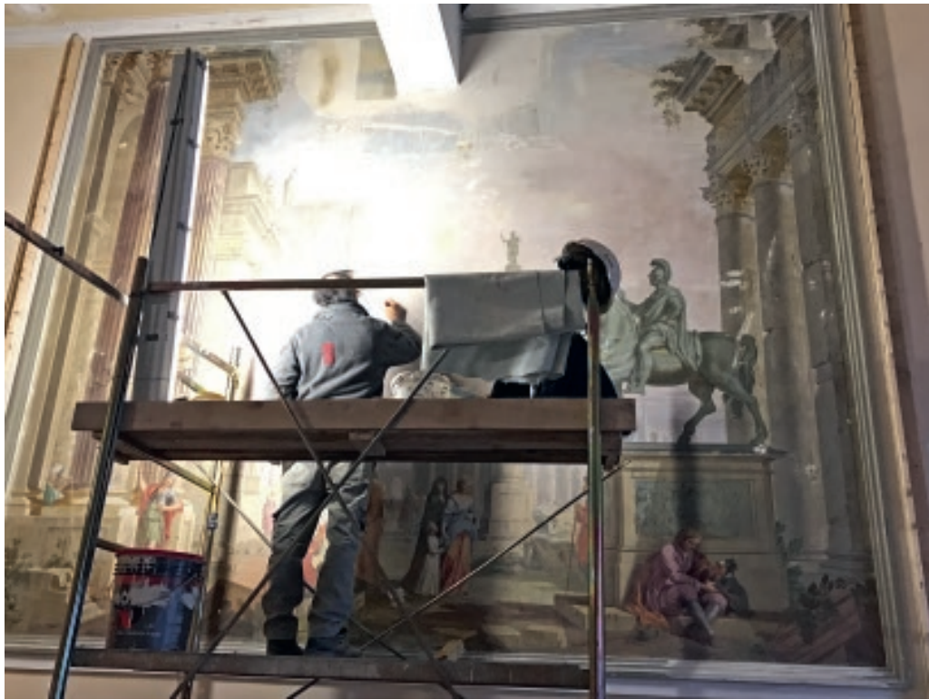
Il cantiere di restauro degli apparati pittorici [© Rossiprodi Associati].
