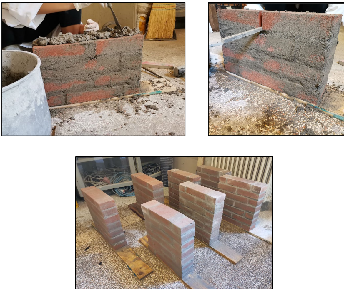
Fig. 5.1 Fase di costruzione dei pannelli murari.
