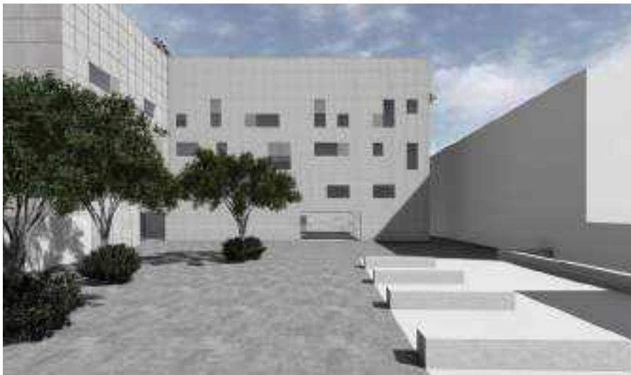
Fig. 2 Vista della nuova piazza lungo l'asse che collega la chiesa con la via Minola Sorelle.
