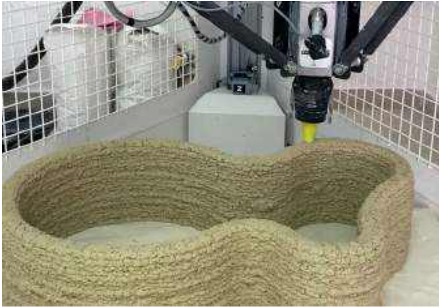
Foto della fase di stampa di un manufatto a scala architettonica con tecnologia Material Extrusion
