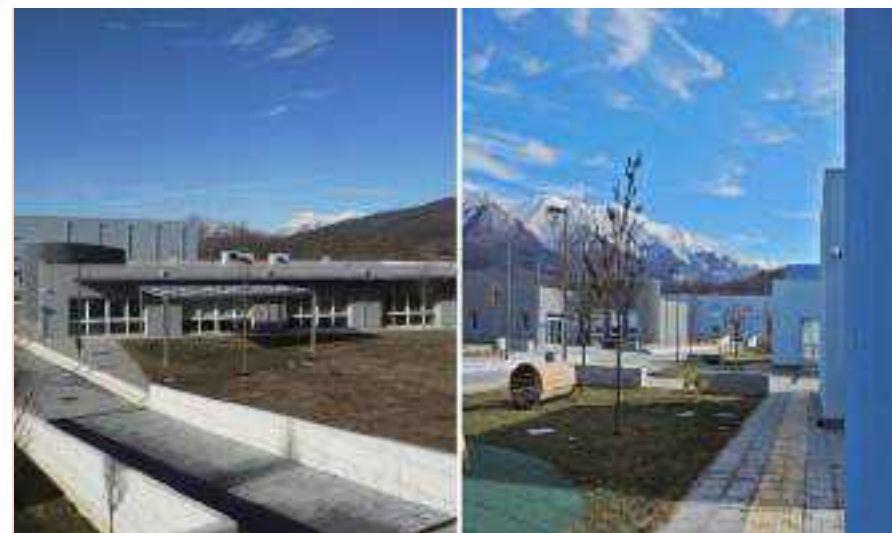
Vedute del Liceo scientifico e dell'impianto spaziale dell'Agorà. Inaugurazione, 18 luglio 2019
