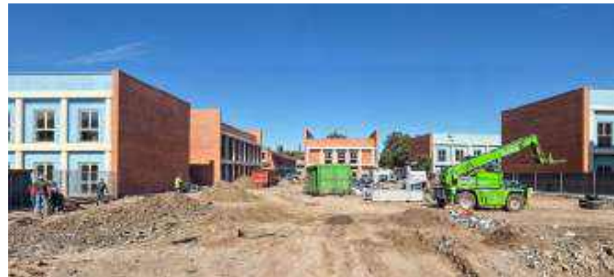
Vista del cantiere del parco della scuola aperto alla collettività
