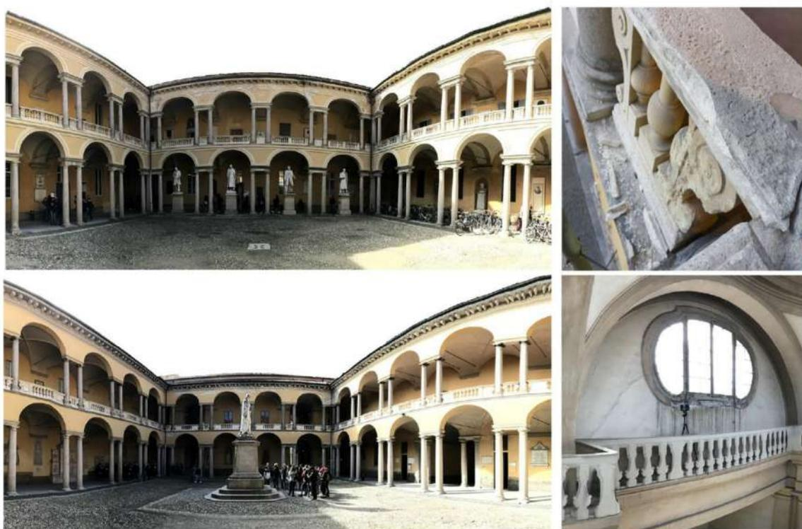
Figura 3. Immagini dei cortili e degli ambienti che caratterizzano il complesso dell'Università Centrale. Il continuo passaggio di persone, l'esposizione a dannosi agenti atmosferici e la scarsa manutenzione determinano una condizione di degrado diffuso sulle superfici murarie, interne ed esterne, dei vari ambienti.
