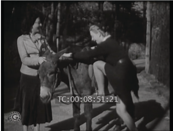
Fig. 7.37 La Fabrication de bas de soie (1937)
