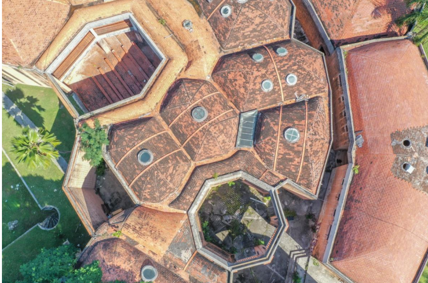
Figura 2 – La Escuela de Arte Dramático (arq. Roberto Gottardi), detalle del techo (elaboración del autor).
