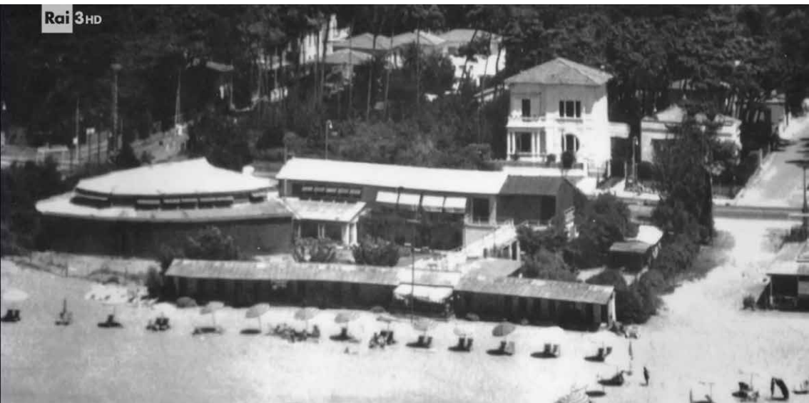
Fig. 13_Le Focette, Marina di Pietrasanta. La Bussola. Vista aerea del dancing dopo la realizzazione della pista da ballo coperta
