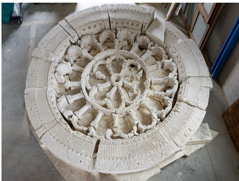
Figura 2. La ricomposizione del rosone della Chiesa di Sant'Eutizio (foto F. Ballotti, 2023).
