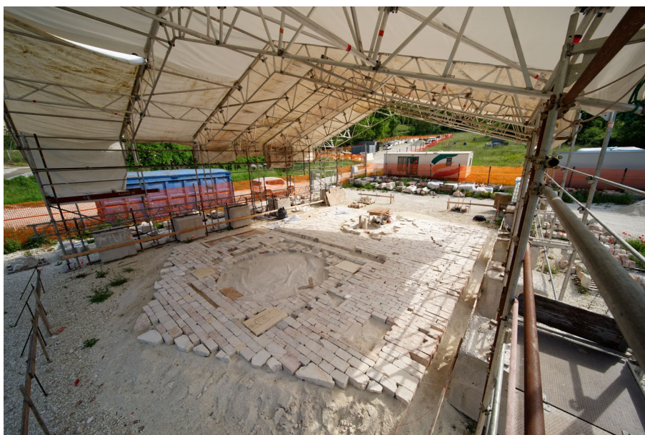
Figura 4. Anastilosi del paramento della facciata della chiesa di Sant'Eutizio (foto P. Pettinari, 2024).
