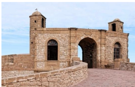
Fig. 8- Marocco, Essaouira, Sqala della kasbah, Borj settentrionale (foto dell'autore)
