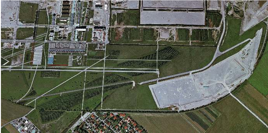
Figura A.1: Riemer Park (Germania) 2001. Parco in costruzione. Si vede l'operazione di préverdissement del bosco.
