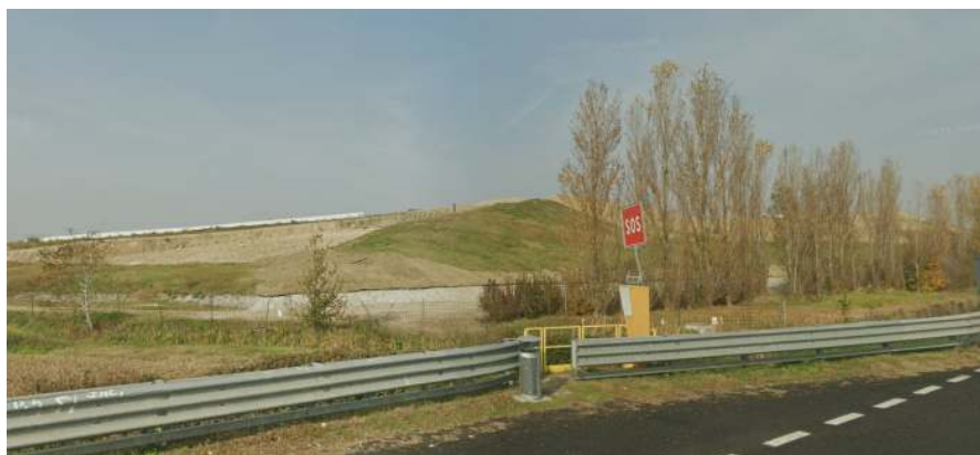
Figura 6.13: Discarica a Castelmaggiore, Bologna; la mediazione rispetto all'autostrada Bologna-Padova, nonostante siano stati previsti successivi ampliamenti, è affidata ad una siepe di pioppi, mentre il progetto di sistemazione paesaggistica della discarica è rimandata alla chiusura del sito; l'arboricoltura potrebbe mediare efficacemente contesti del genere.
