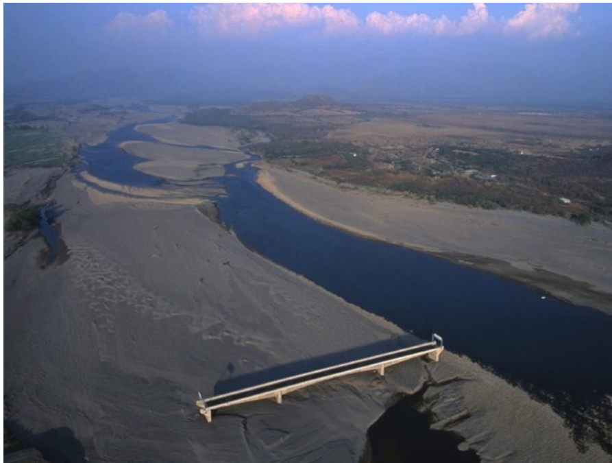
Figura 6.2: Ponte di Choluteca (Honduras). Il fiume ha «abbandonato» il ponte dopo una piena dovuta ad un uragano.
