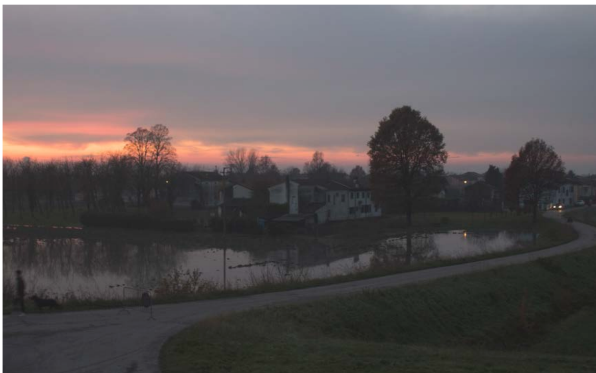
Fig. 1.21 - L'acqua supera il confine arginale per infiltrazione durante un evento di piena nel 2019, Villastrada (MN) Foto: Maicol Rossi
