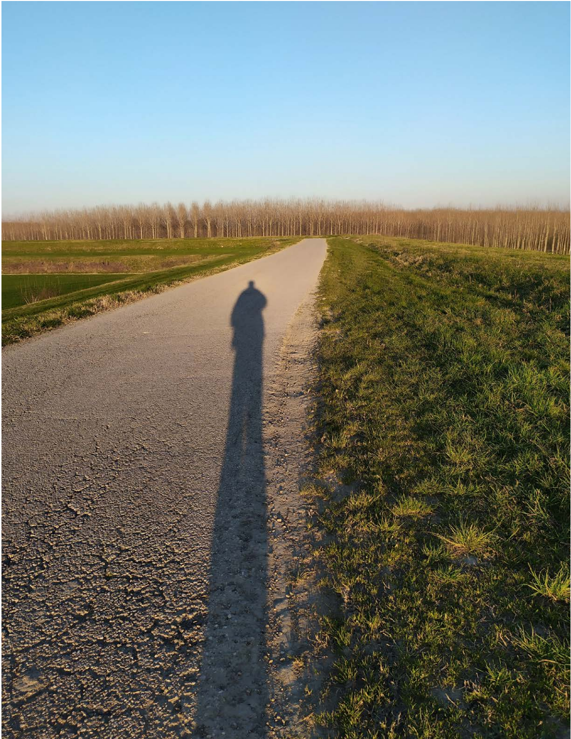
Fig. 4.2 - Argine di Villastrada (MN) Foto: Maikol Rossi
