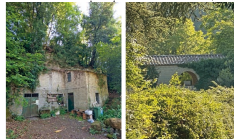
Fig. 22.VI Edificio attualmente presente all'interno del bosco, su piano inferiore rispetto alla Cattedrale
