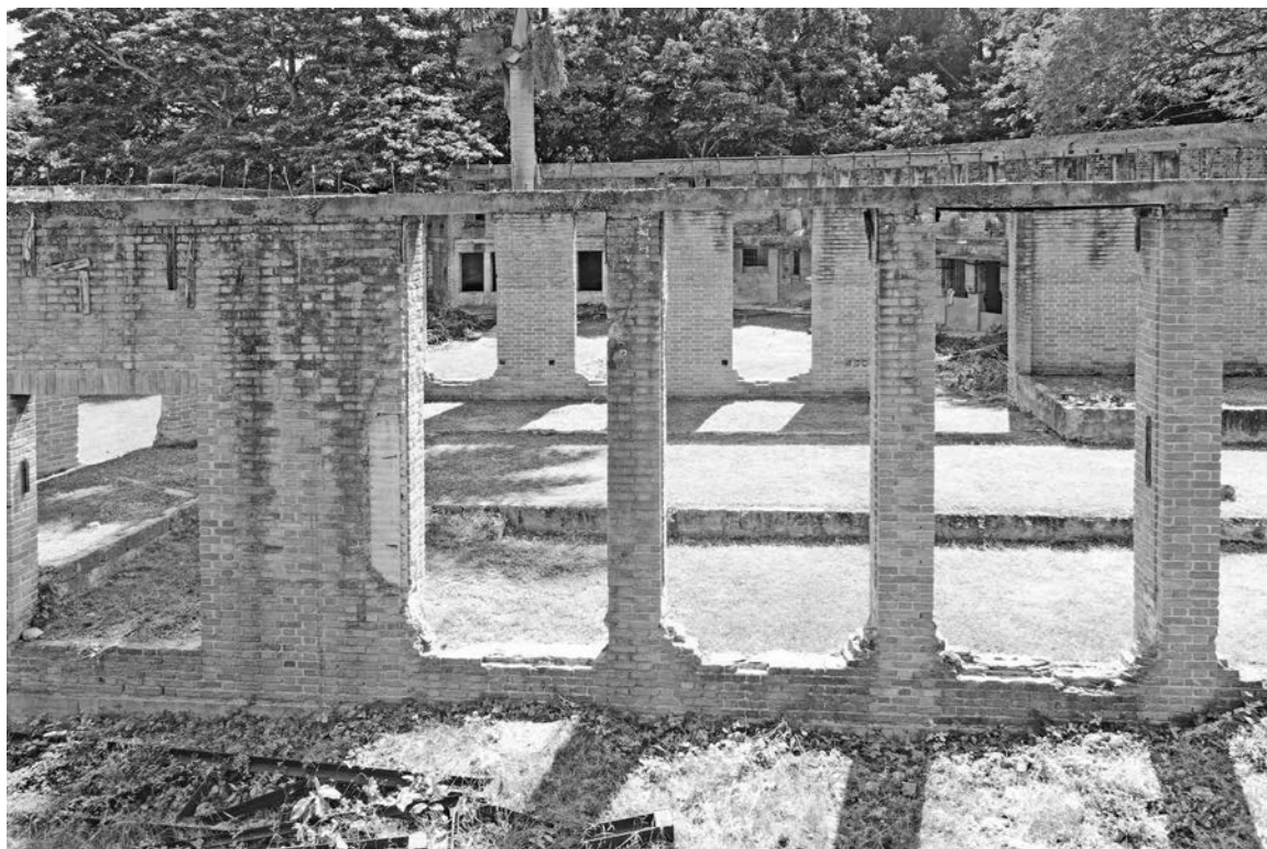
Fig. 39 | Pilares y tabiques de mampostería del bloque 13 (créditos: CHM_Lab). | Pilastrì e setti in muratura del blocco 13 (credits: CHM_Lab).
