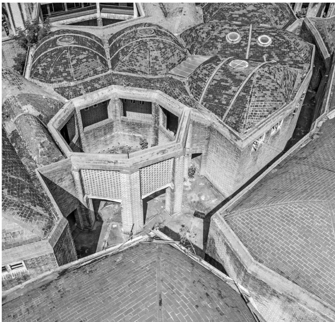
Fig. 27 | Patio octogonal entre los bloques 6, 7 y 8 (foto con dron) (créditos: CHM_Lab). | Piazza ottagonale tra i blocchi 6, 7 e 8 (foto da drone) (credits: CHM_Lab).
