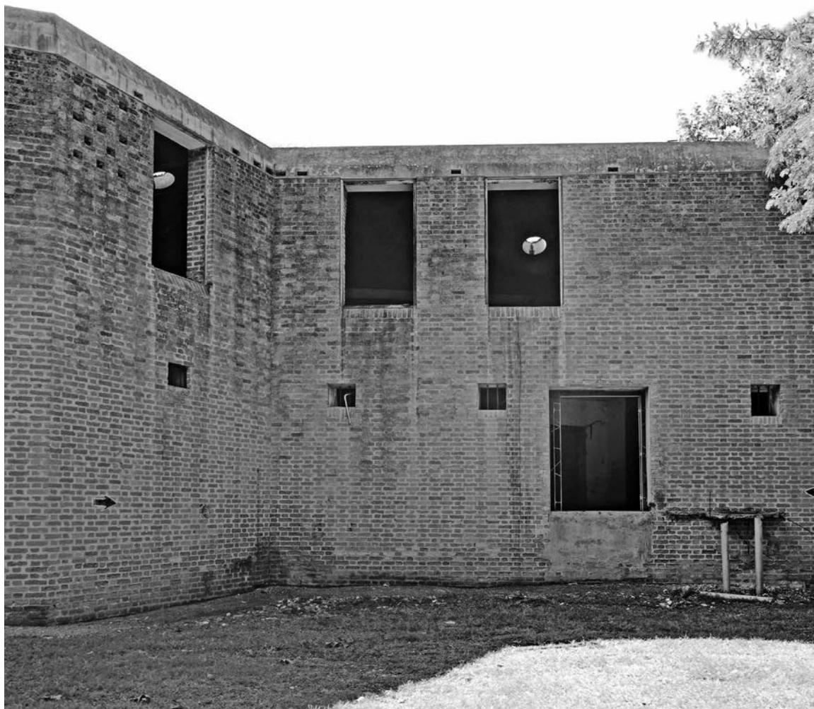
Fig. 24 | Alzado exterior del bloque 4 (créditos: CHM_Lab). | Prospetto esterno del blocco 4 (credits: CHM_Lab).
