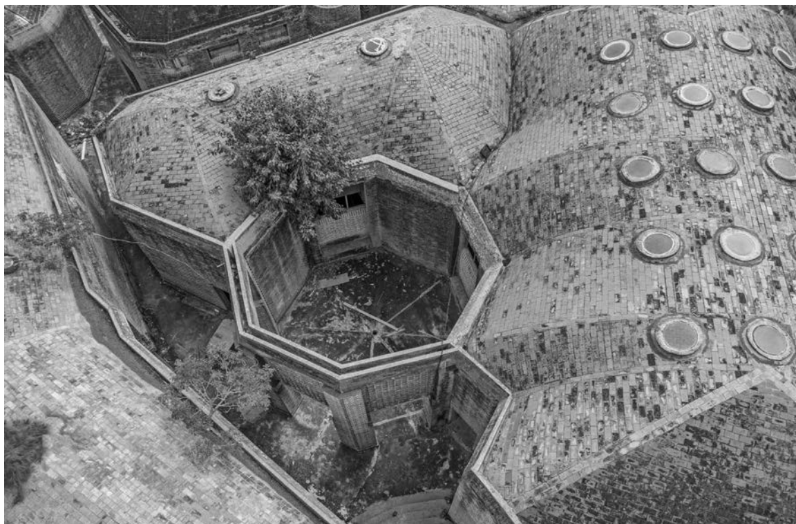
Fig. 29 | Patio octogonal entre los bloques 10 y 11 (foto con dron) (créditos: CHM_Lab). | Piazza ottagonale tra i blocchi 10 e 11 (foto da drone) (credits: CHM_Lab).
