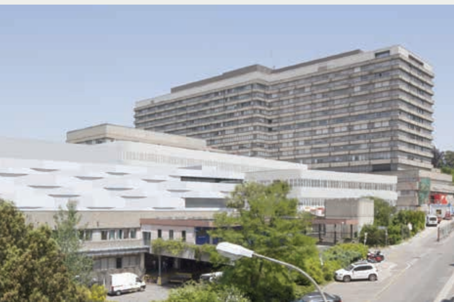
■ Centre Hospitalier Universitaire Vaudois (CHUV), Losanna. Facciata del nuovo blocco operatorio transitorio e centro di endoscopia. Progettisti: meier + associés architectes, Ginevra, e bureau d'étude façades artesa, Chexbres
