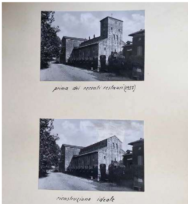
Fig. 1 Sezzadio (AL), Abbazia S. Giustina - la Chiesa - lato Nord, cartoline, 1954 (SABAP-To, Archivio Fotografico della Soprintendenza ai Monumenti del Piemonte - Torino, n. 13.312 bis).
