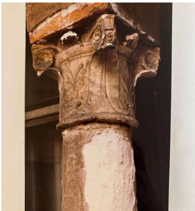
Fig. 7 Milano, Casa Silvestri, colonna del Cortile d'onore affetta da diffusi fenomeni di degrado nel 1993. ASABAP-Mi - tutti i diritti riservati, cartella D2 826 II-III.
