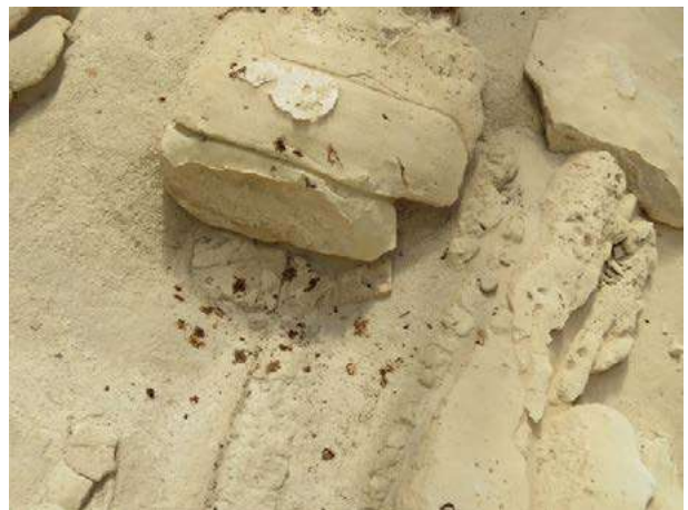
Fig. 5. Eraclea Minoa, vista interna del teatro sovrastato dalla copertura protettiva (in alto). Figg. 6-9. Le forme di degrado degli elementi lapidei della cavea: fratturazioni, efflorescenze saline, disgregazione e depositi superficiali (foto G. M. Ventimiglia, 2023).
