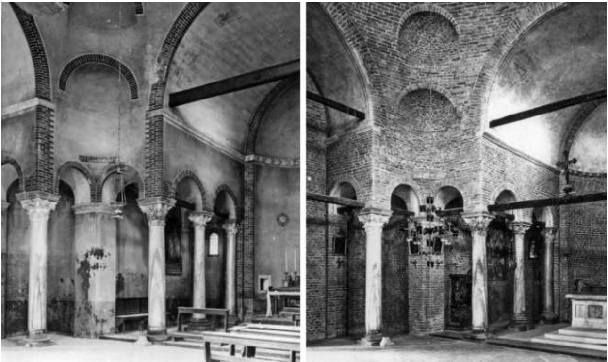
Fig. 2. Torcello, chiesa di S. Fosca: a sinistra, prima dei Lavori di Forlati del 1929-1938, si nota la presenza dei tiranti lignei del braccio absidale (solo all'imposta dell'arcone) e delle due arcate del presbiterio, inoltre le superfici intonacate nella fase dell'intervento di Berchet-Rupolo (1911-1915) con campiture bianche e finti mattoni nelle angolate e nelle arcate (foto del giugno 1929) (SABAPVeLag); a destra, Torcello, chiesa di S. Fosca, dopo i lavori di Forlati del 1929-1938, si nota l'incremento dei tiranti lignei negli arconi dei bracci della croce e in tutte le arcatelle e la rimozione intonaco precedente lasciando muratura a vista e volte intonacate di bianco con filetti perimetrali di colore blu e rosso (foto del ottobre 1938) (SABAPVeLag)
