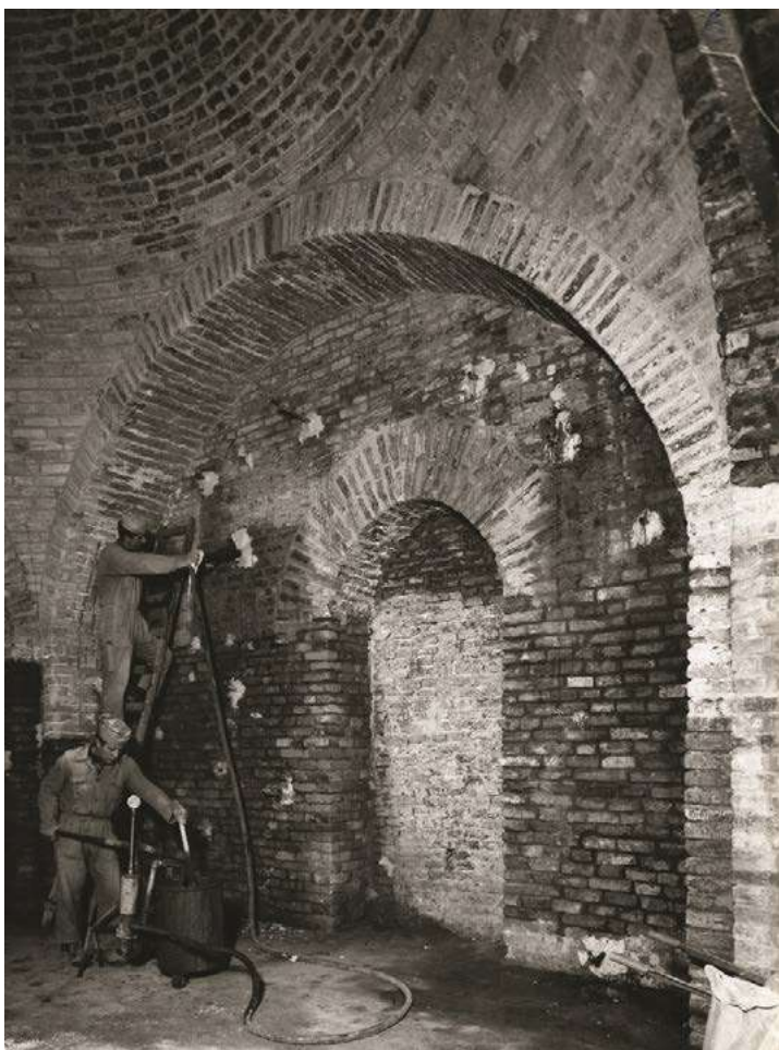
Fig. 3. Operai impegnati nella realizzazione di consolidamenti tramite iniezioni cementizie a pressione nel cantiere marciano, anni '60 circa, (Università Iuav di Venezia, Archivio Progetti – Fondo Ferdinando Forlati)
