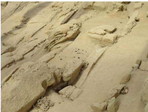
Fig. 5. Eraclea Minoa, vista interna del teatro sovrastato dalla copertura protettiva (in alto). Figg. 6-9. Le forme di degrado degli elementi lapidei della cavea: fratturazioni, efflorescenze saline, disgregazione e depositi superficiali (foto G. M. Ventimiglia, 2023).
