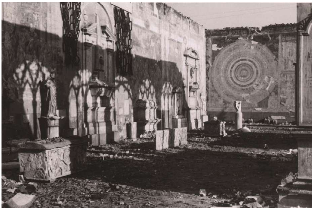
Fig. 3 Pisa, Camposanto Vecchio dopo l'incendio del 27 luglio 1944. Il soprintendente Piero Sanpaolesi avvia i lavori di recupero dei lacerti e le operazioni di stacco degli affreschi, avvalendosi di una quadra operativa di valenti restauratori tra cui Leone Lorenzetti e Leonetto Tintori con il supporto scientifico dell'Istituto Centrale del Restauro diretto da Cesare Bandi (foto di J. B. Ward Perkins, British School at Rome Archive, Ward-Perkins Collection, wpward 0840)
