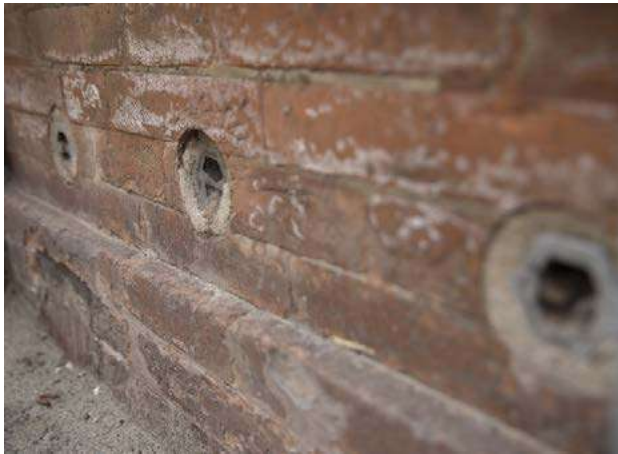
Fig. 4 Ferrara, Palazzo Renata di Francia, applicazione dei sifoni Knapen (foto M. Montuori 2016).
