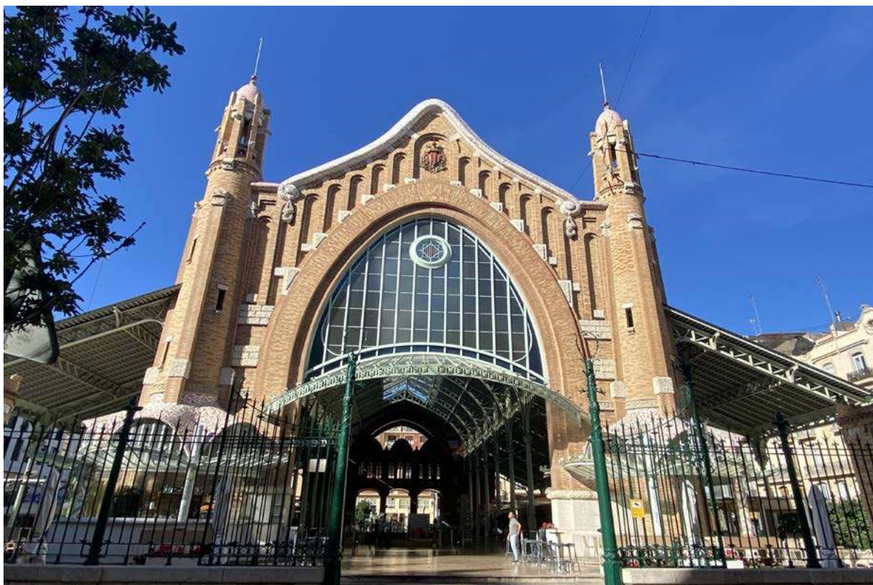
Fig. 4. Valencia, Mercato Colón. Facciata Est su via Conde de Salvatierra. (Foto degli autori, 2023)
