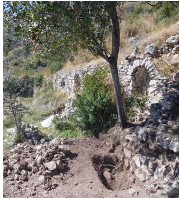
Fig. 2 Crapolla (Massa Lubrense), Abbazia di San Pietro. Il fronte nord in corrispondenza degli ambienti adibiti a residenze dei monaci (foto S. Pollone 2017).
