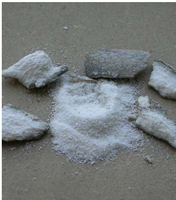
Fig. 2. Venezia, Chiesa di S. Maria di Nazareth (degli Scalzi), Documentazione fotografica del campione 4041/6 prelevato dalla facciata, (foto M. Baldan, 2015 in Archivio SABAP-VE-LAG).
