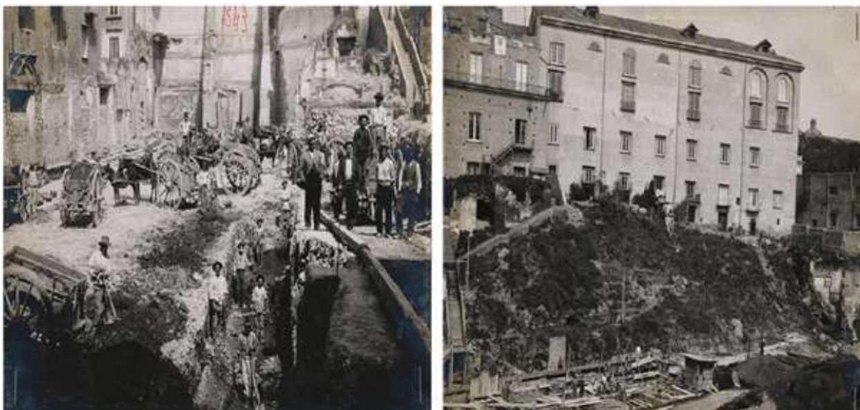
Figg. 3 - 4 Immagini dello scavo all'interno del cortile della Minerva nel 1906 e 1912.
