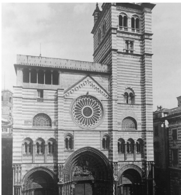
Fig. 1. Genova, Cattedrale di San Lorenzo, la facciata alla fine del XIX secolo in cui si notano le finestre termali e il muro costruito sopra il frontone della chiesa, che unisce la loggia a sinistra con la torre campanaria a destra, (foto C. Degoix, 1870-80, in Archivio Alinari, Firenze, FBQ-F-001153-0000)
