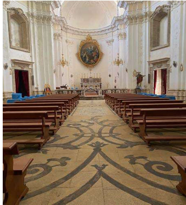
Fig. 6 Siracusa, chiesa di S. Filippo Neri, pavimento aula, si notano i banchi di legno che danneggiano le pietre restaurate (foto O. Schillaci, 2023)
