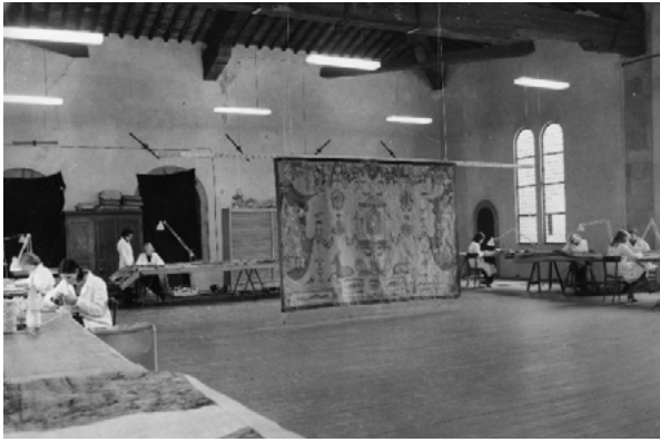
Fig. 2. Firenze, Palazzo Vecchio. Laboratorio di restauro nella Sala delle Bandiere durante la preparazione della mostra sul collezionismo mediceo (foto archivio OPD, 1980)
