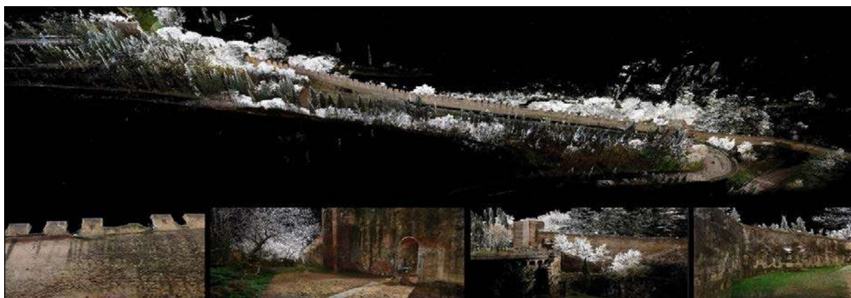
Fig. 4 Alcune immagini del database point cloud integrato. La nuvola di punti oltre ad essere altamente descrittiva della tessitura muraria, permette la lettura colorimetrica del manufatto riportando l'immagine dello stato di conservazione alla data del rilievo effettuato.
