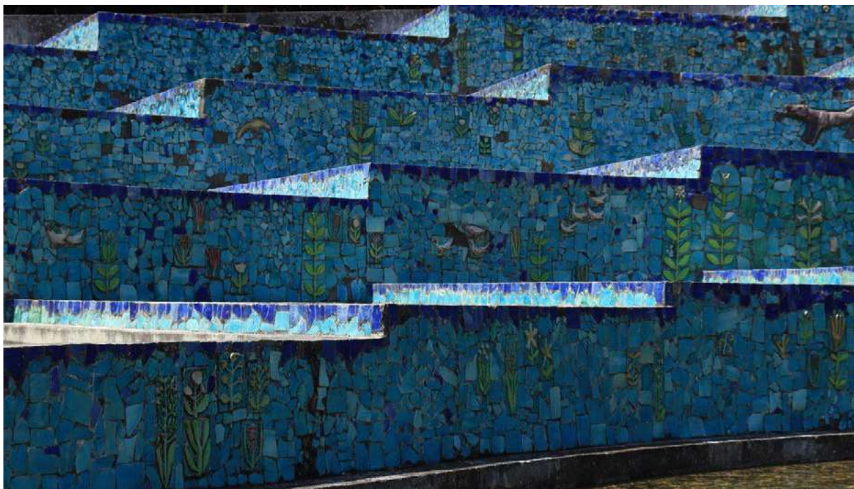
Fig. 2 Napoli, Fontana dell'Esedra, Mostra d'Oltremare. Dettaglio del rivestimento ceramico soggetto a problematiche relative al contatto con l'acqua (foto S. Iaccarino 2021).
