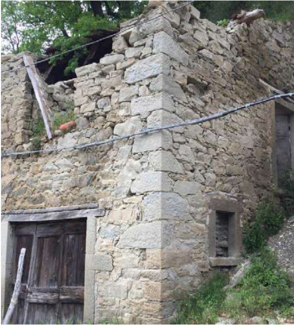
Fig. 1 Tipologia prevalente di muratura presente negli edifici di Vezzano (foto E. Petrucci).
