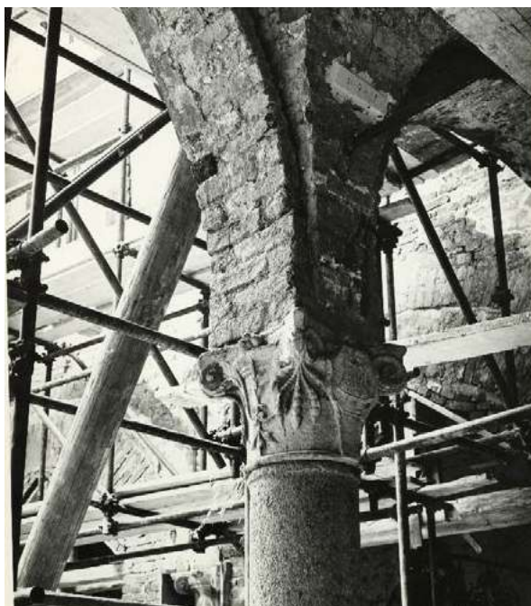
Fig. 6 Milano, Casa Silvestri, presidi strutturali nel porticato del Cortile d'onore. Archivio del Centro Studi e Archivio della Comunicazione dell'Università di Parma, Fondo Reggiori, 360/1.
