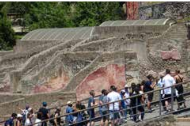
109. Suasa (AN), Anfiteatro, l'allagamento della cavea per mancata manutenzione dei fossi delle aree agricole limitrofe (foto A. Ugolini 2013)
