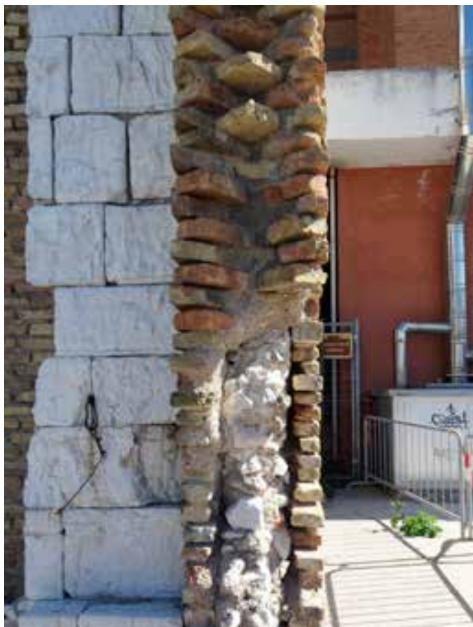
88. Suasa (AN), Anfiteatro, stato di conservazione dei bauletti di restauro e della muratura antica (foto A. Ugolini 2013)
