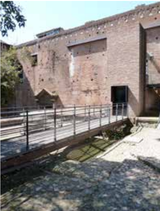
184. Roma, Mercati di Traiano, passerelle. Progetto L. Franciosini e R. D'Aquino (foto A. Ugolini 2013)
