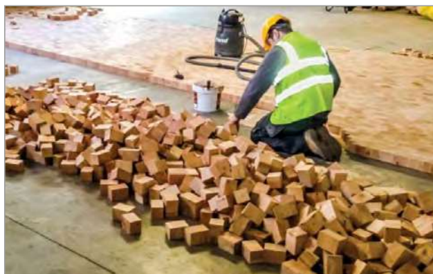
Moderna realizzazione di pavimentazione all'interno con i blocchi di legno.
