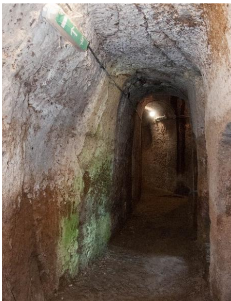
Fig. 6- Sorano, Fortezza Orsini; cunicolo del bastione di San Pietro scavato nella roccia (foto Riccardo Righini, Chiara Zucconi, 2020)
