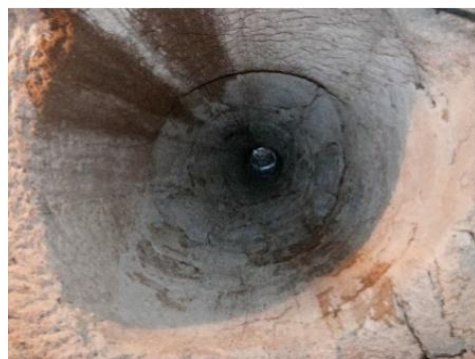
Fig. 7- Sorano, Fortezza Orsini, bastione di San Pietro; camino di ventilazione scavato nella roccia (foto di Riccardo Righini, Chiara Zucconi, 2020)
