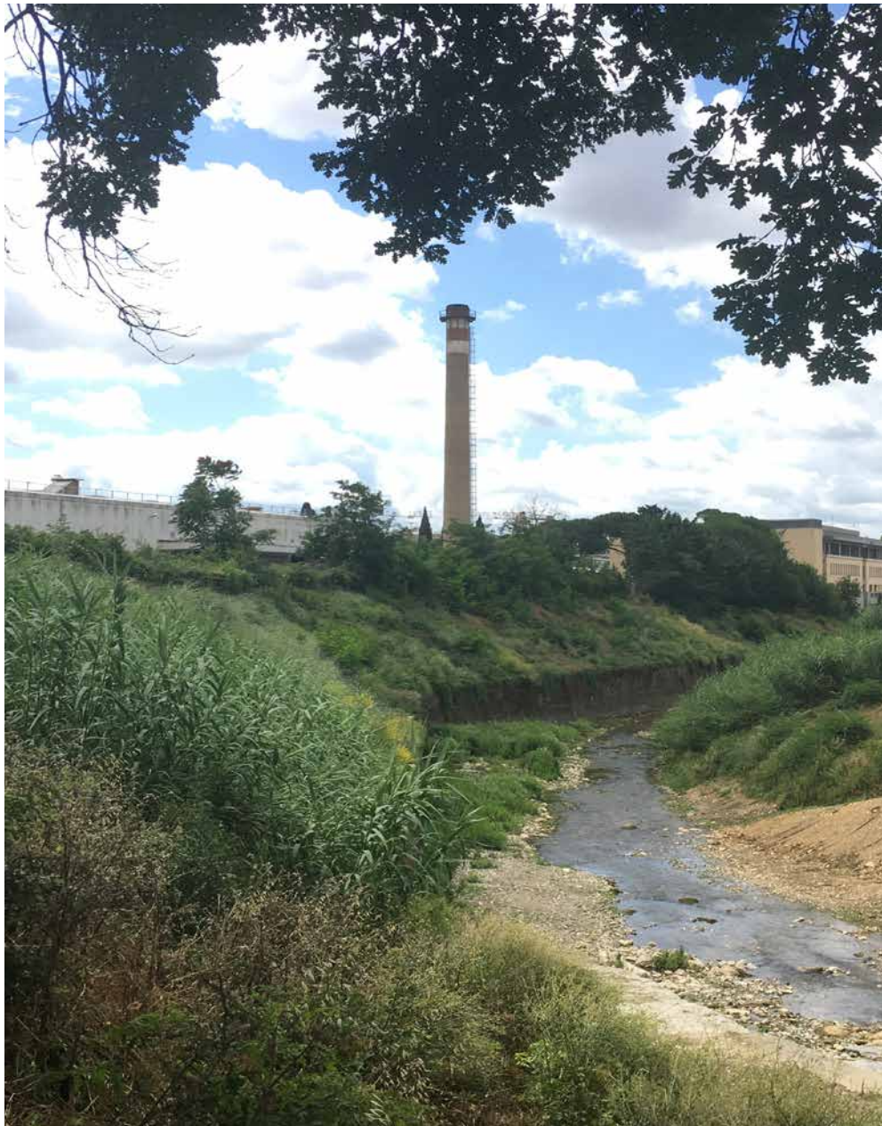
➔ fig. 5 Careggi, Pontenuovo. Il torrente Terzolle verso valle, con il complesso della AUC sulla sinistra idrografica.
