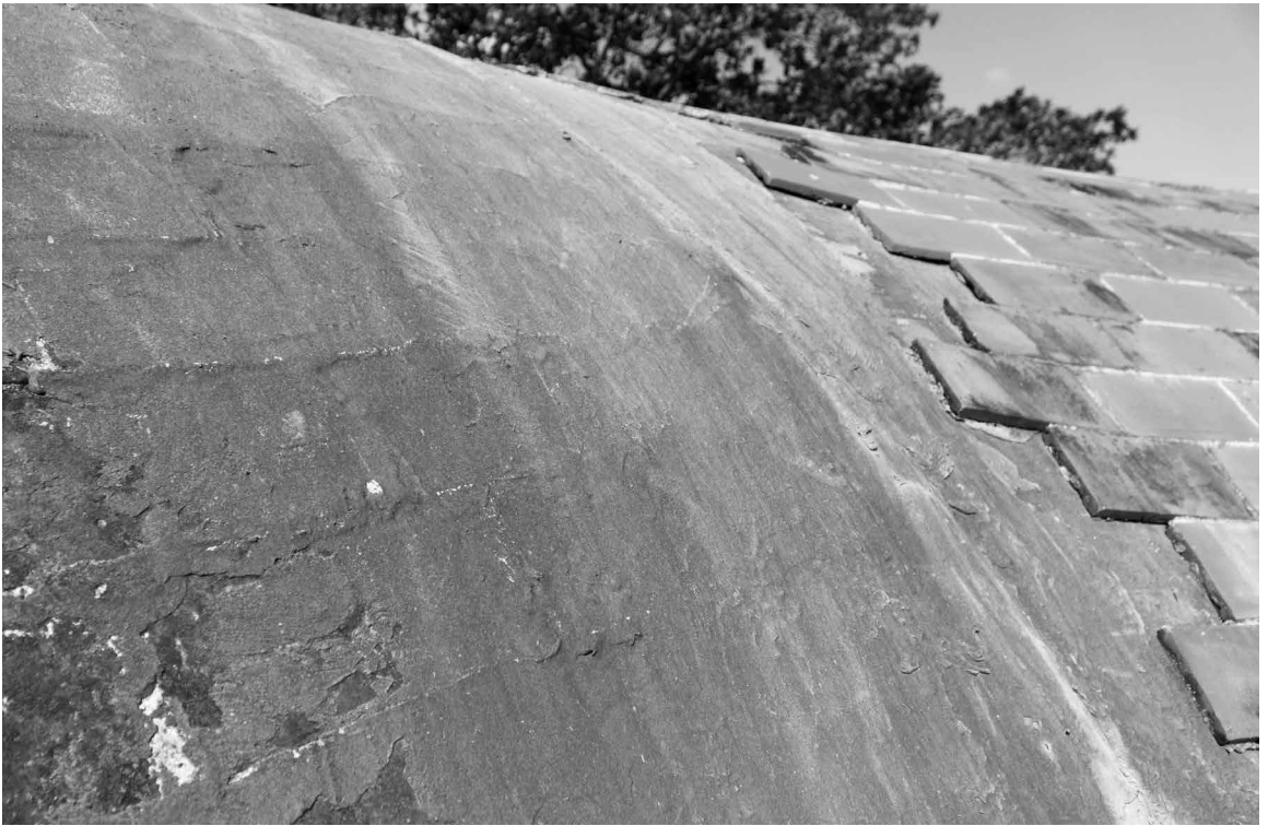
Fig. 25 | Ejemplo de cuadro de fisuras en estructuras verticales (créditos: Sara Garuglieri). | Esempio di quadro fessurativo in strutture verticali (credits: Sara Garuglieri).
