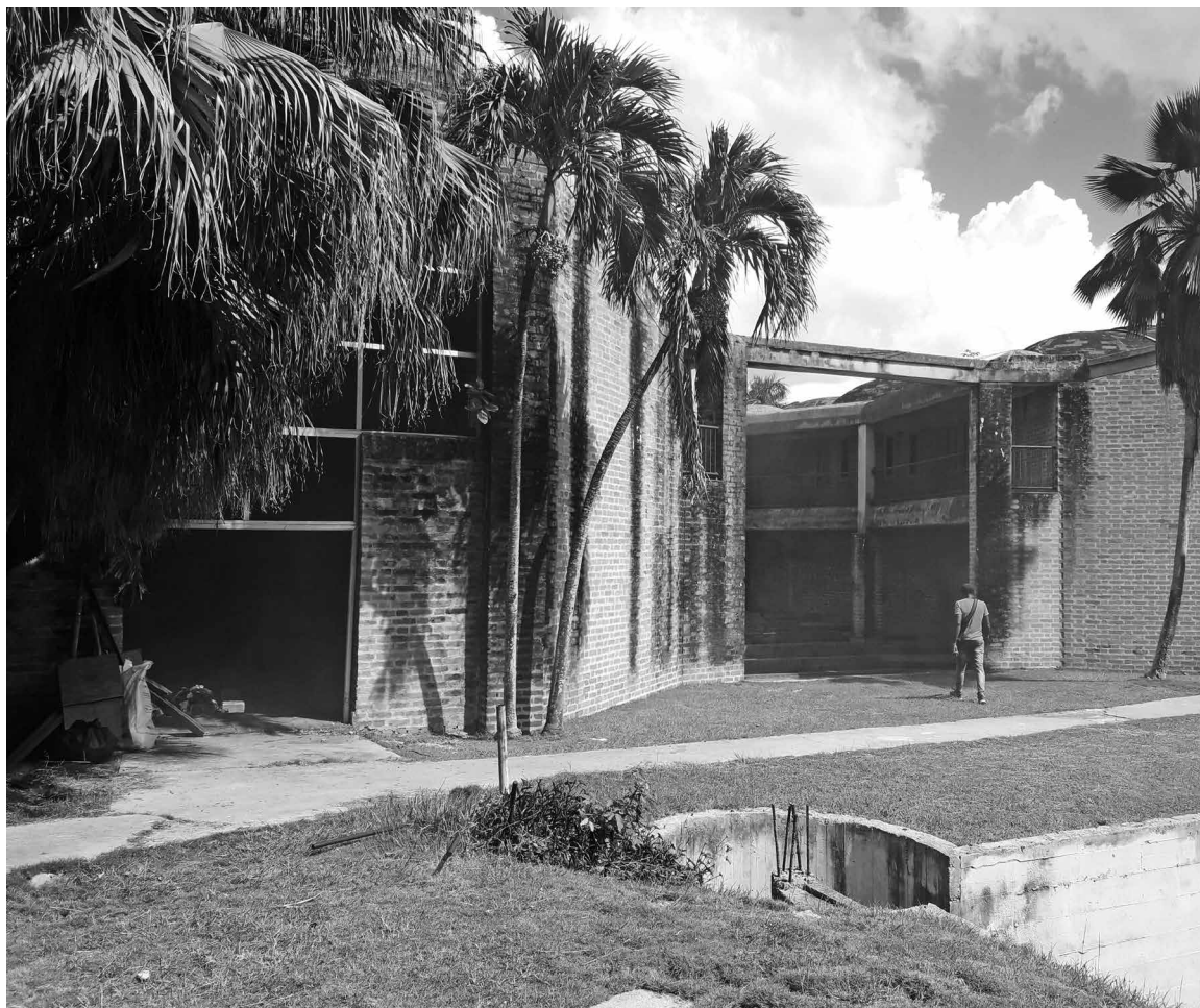
Fig. 34 | Alzado exterior de los bloques 11 y 12 (créditos: CHM_Lab). | Prospetto esterno dei blocchi 11 e 12 (credits: CHM_Lab).
