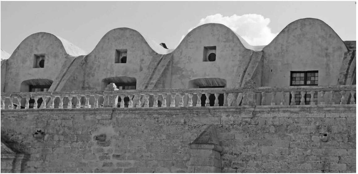
Fig. 18 | Detalle de la coronación sinuosa del muro lateral de la iglesia del convento de San Francisco de Asís, formada por las bóvedas de los lunetos laterales y las contracurvas de desagüe entre ellos (créditos: Vegas & Mileto). | Particolare del coronamento sinuoso della parete laterale della chiesa del Convento de San Francisco de Asís , formato dalle lunette delle volte laterali e dalle controcurve di drenaggio poste tra le prime (credits: Vegas & Mileto).
