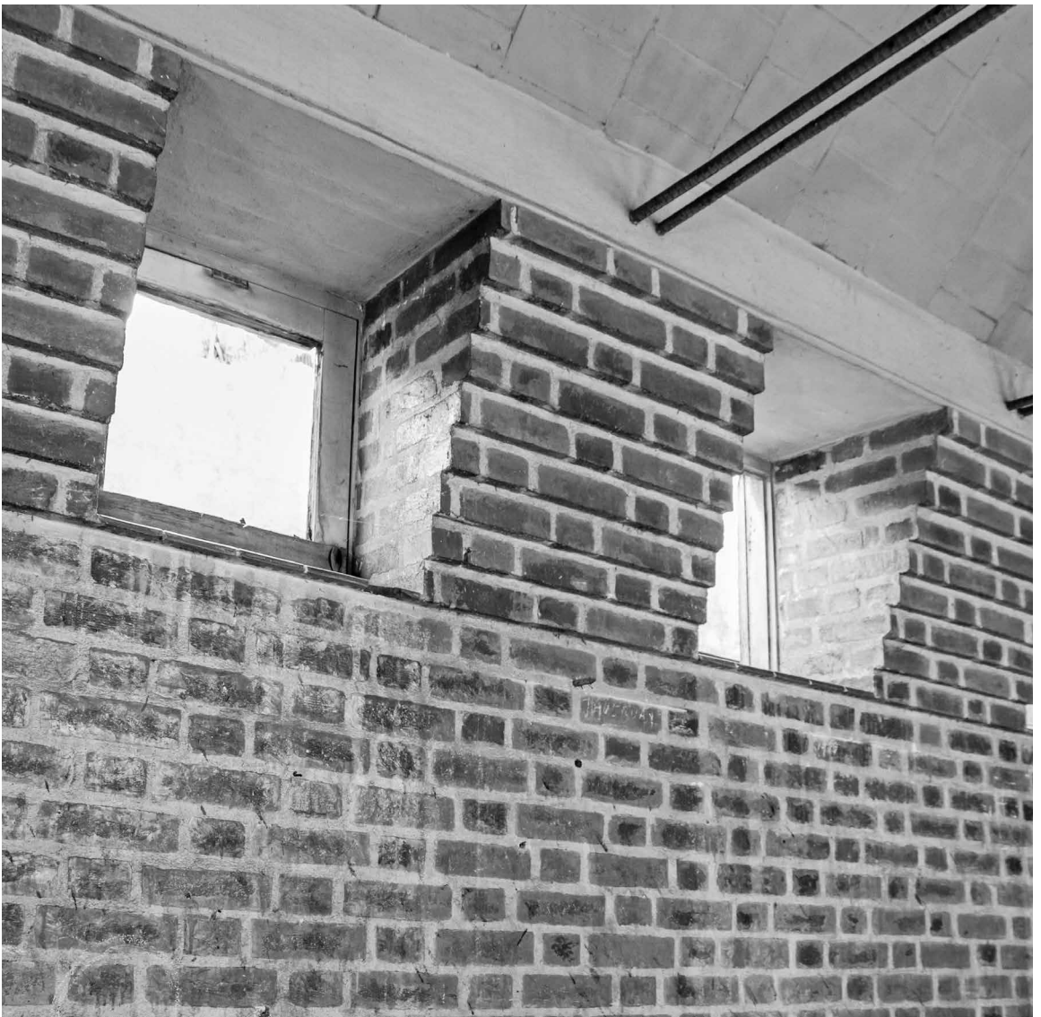
Fig. 12 | Detalle del aumento de la profundidad de los muros mediante escalonamiento (créditos: CHM_Lab). | Dettaglio dell'aumento di profondità delle pareti tramite gradinatura (credits: CHM_Lab).
