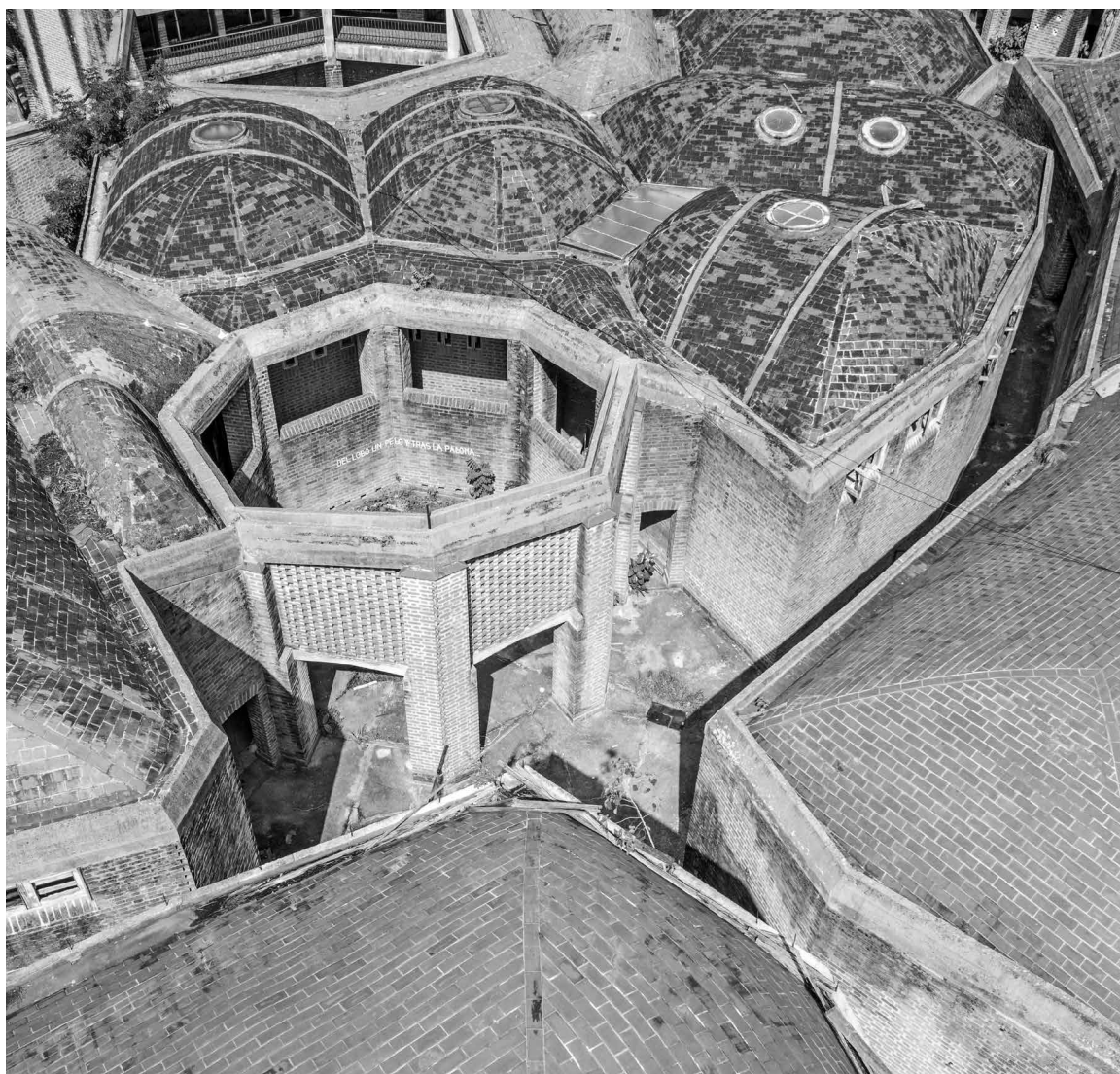
Fig. 27 | Patio octogonal entre los bloques 6, 7 y 8 (foto con dron) (créditos: CHM_Lab). | Piazza ottagonale tra i blocchi 6, 7 e 8 (foto da drone) (credits: CHM_Lab).
