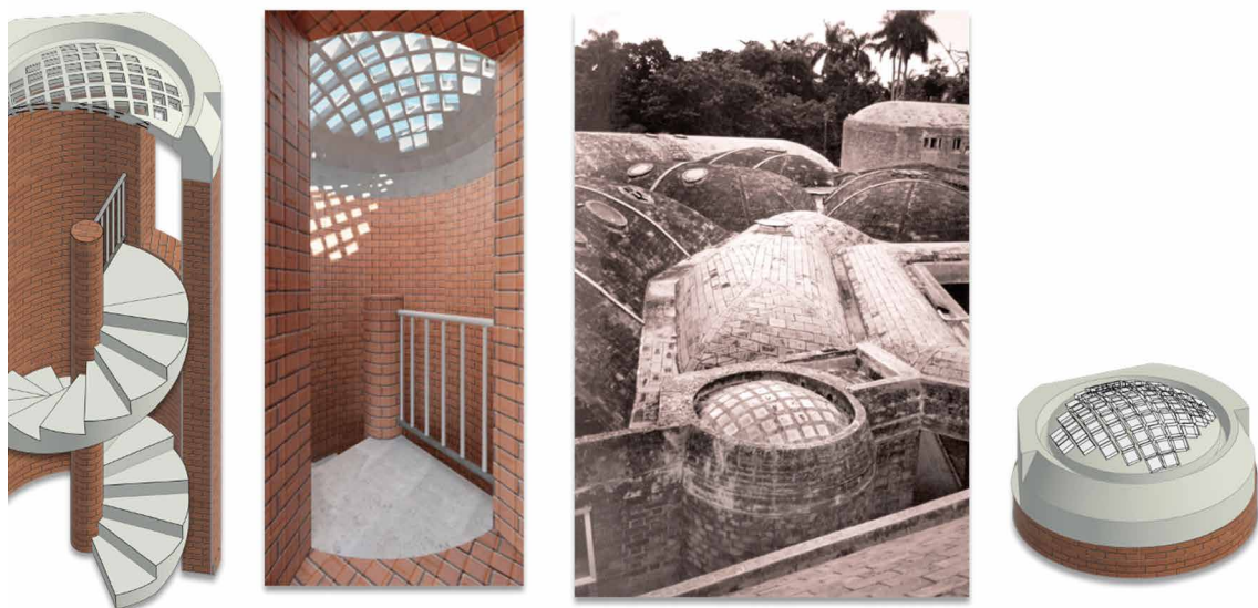
Fig. 27 | Representación de la cubierta de ladrillos de vidrio en el bloque 9. | Rappresentazione della copertura in vetro cemento nel blocco 9.
