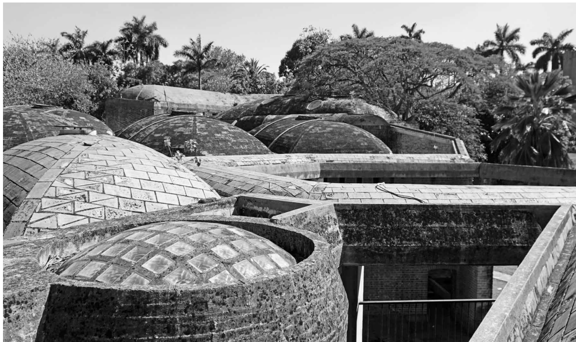
Fig. 1 | Bóvedas que cubren los bloques de la FAT (créditos: Alessandro Merlo). | Volte di copertura dei blocchi della FAT (credits: Alessandro Merlo).
