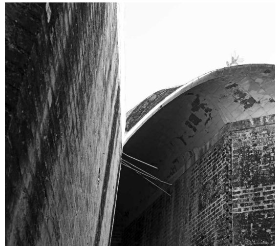
Fig. 15 | Incrustación inducida por goteo y/o percolación, generalizada y constante en el tiempo (créditos: Stefania Aimar). | Incrostazione indotta da colature e/o percolamenti diffusi e costanti nel tempo (credits: Stefania Aimar).
