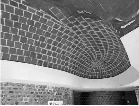
Fig. 10 | Bóveda anular de cañón de cuerda constante apoyada sobre vigas continuas de hormigón e interrumpida eventualmente con lunetos de acceso a las aulas en la Escuela de Artes Plásticas de Ricardo Porro (créditos: Vegas & Mileto). | Volta a botte anulare a corda costante sostenuta da travi continue in cemento armato, interrotta da lunette per dare accesso alle aule della Escuela de Artes Plásticas di Ricardo Porro (credits: Vegas & Mileto).
