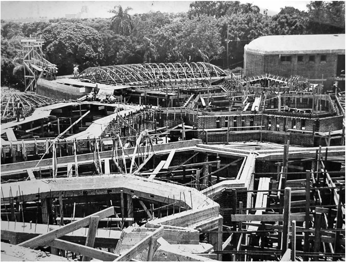
Fig. 17 | Fotografía de la Escuela de Teatro en construcción. Destacan los zunchos de hormigón armado que actúan como punto de apoyo de las cubiertas abovedadas; al fondo, las nervaduras dispuestas para la colocación de las diferentes capas de rasillas (cortesía de Roberto Gottardi). | Fotografia della Scuola di Teatro in costruzione. In evidenza i cordoli in cemento armado che fungono da punto di appoggio per le coperture voltate; sullo sfondo le centine posate in opera per la posa dei diversi strati di tavelle (cortesía di Roberto Gottardi).
