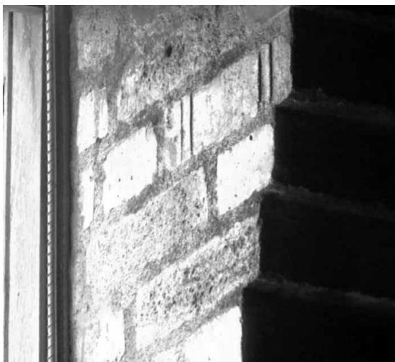
Fig. 13 | Izquierda: Escuela de Ballet, foto de la parte inferior de una rasilla con el nombre de los tejares de origen impreso. Derecha: Escuela de Teatro, detalle de un tabique con el sistema de identificación impreso en los ladrillos (fotografías de Christian Zecchin). | A sinistra: Scuola di Balletto, foto del fondo di una tavella con impresso il nome del tejares di provenienza. A destra: Scuola di Teatro, dettaglio di un setto murario con in evidenza il sistema di riconoscimento impresso sui mattoni (fotografie di Christian Zecchin).
