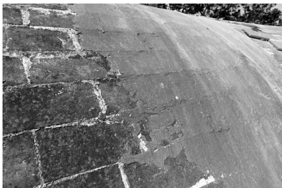
Fig. 26 | Bloque 3, extradós, obras de restauración anteriores de los años 2005-2008 que quedaron inconclusas (créditos: Sara Garuglieri). | Blocco 3, estradosso, interventi di restauro pregressi databili tra gli anni 2005-2008 e rimasti inconclusi (credits: Sara Garuglieri).
