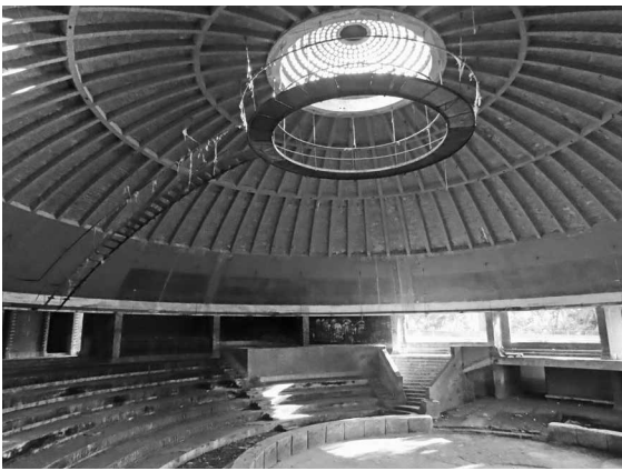
Fig. 27 | Vista del intradós de una de las grandes bóvedas vaídas de la Escuela de Ballet de Vittorio Garatti, con sus nervaduras de hormigón sobre encofrado perdido de rasilla cerámica que mantienen la continuidad material y protegen las armaduras de la corrosión (créditos: Vegas & Mileto). | Veduta dell'intradosso di una delle grandi volte a bacino della Escuela de Ballet di Vittorio Garatti, con le sue nervature in cemento realizzate con cassero a perdere di piastrelle in laterizio che mantengono la continuità materica e proteggono le armature dalla corrosione (credits: Vegas & Mileto).
