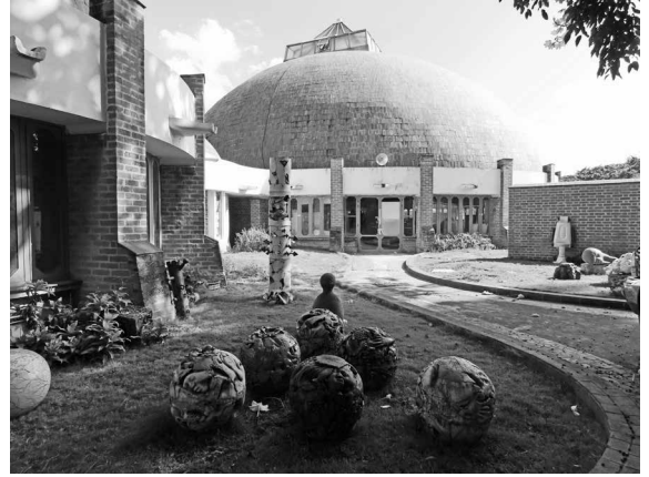
Fig. 10 | Bóveda anular de cañón de cuerda constante apoyada sobre vigas continuas de hormigón e interrumpida eventualmente con lunetos de acceso a las aulas en la Escuela de Artes Plásticas de Ricardo Porro (créditos: Vegas & Mileto). | Volta a botte anulare a corda costante sostenuta da travi continue in cemento armato, interrotta da lunette per dare accesso alle aule della Escuela de Artes Plásticas di Ricardo Porro (credits: Vegas & Mileto).
