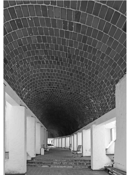
Fig. 14 | Pórtico metafórico danzante conformado por gruesos nervios de hormigón y bóvedas vaídas o de pañuelo tendidas entre ellos en la Escuela de Danza Moderna de Ricardo Porro (créditos: Vegas & Mileto). | Portico metaforicamente danzante costituito da spesse nervature di cemento e volte a vela o a fazzoletto accostate tra loro nella Escuela de Danza Moderna di Ricardo Porro (credits: Vegas & Mileto).
