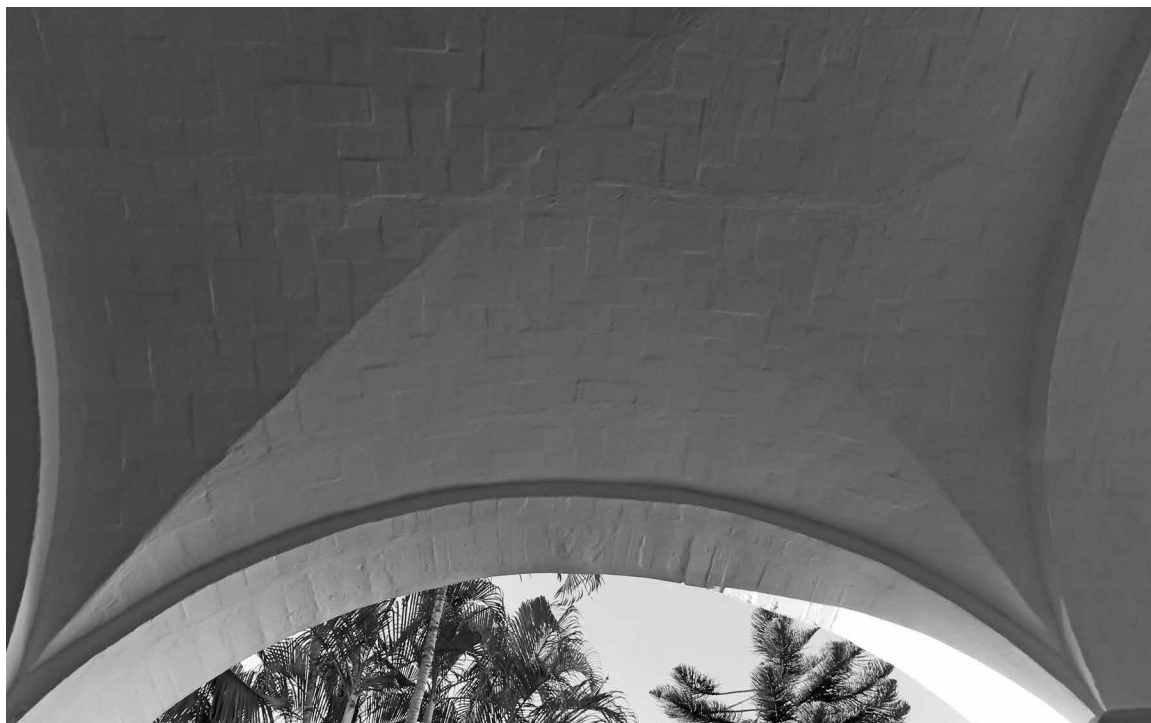
Fig. 8 | Detalle del aparejo en espina de pez de las bóvedas de arista del claustro del Convento de Santa Catalina de Siena en El Vedado, construidas por Rafael Guastavino hijo en 1914 (créditos: Vegas & Mileto). | Particolare dell'apparecchiatura a spina di pesce delle volte a crociera del Convento de Santa Catalina de Siena nel El Vedado , costruito da Rafael Guastavino Jr. nel 1914 (credits: Vegas & Mileto).
