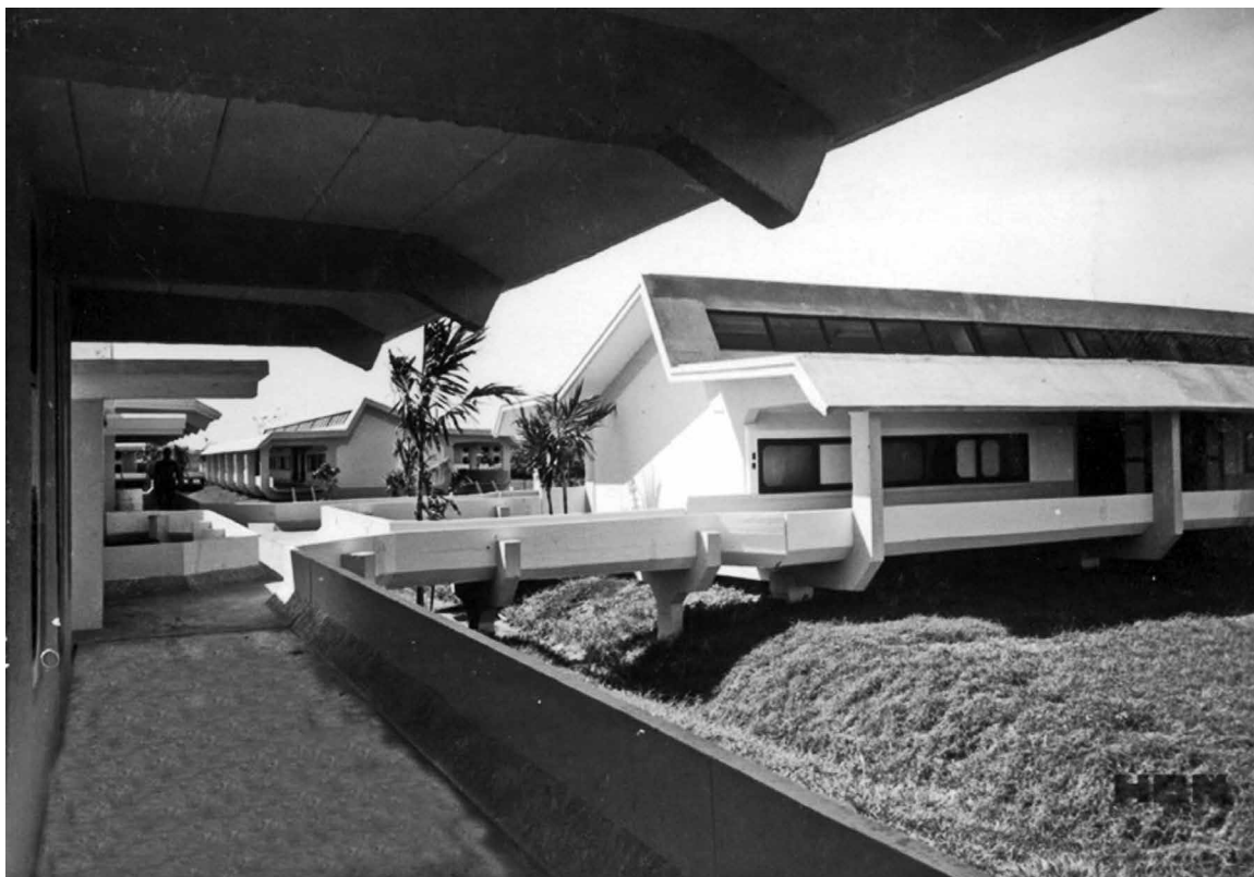
Fig. 8 | Vittorio Garatti, Instituto Tecnológico de Suelos y Fertilizantes André Voisin 1962-1965; vista de los caminos internos (fuente: Arquitectura Cuba edición digital www.arquitecturacuba.com ). | Vittorio Garatti, Instituto Tecnológico de Suelos y Fertilizantes André Voisin 1962-1965; vista dei percorsi interni (fonte: Arquitectura Cuba edizione digitale www.arquitecturacuba.com ).
