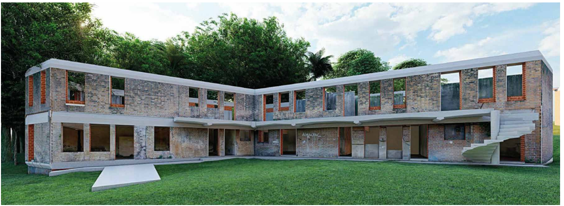
Fig. 59 | Vista 3D renderizada del bloque 14 mediante la utilización del software Lumion. | Vista 3D renderizzata del blocco 14 tramite l'utilizzo del software Lumion.
