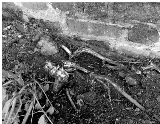
Fig. 14 | Imágenes del trabajo técnico de inspección de los bajantes pluviales (créditos: Alida Diez Sánchez, 2023). | Immagini dei lavori di ispezione dei pluviali (credits: Alida Diez Sánchez, 2023).
