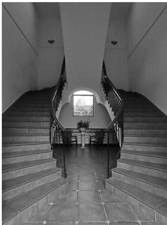
Fig. 9 | Escalera doble del claustro del Convento de Santa Catalina de Siena en El Vedado, construidas por Rafael Guastavino hijo en 1914 (créditos: Vegas & Mileto). | Doppia rampa del chiostro del Convento de Santa Catalina de Siena nel El Vedado , costruita da Rafael Guastavino Jr. nel 1914 (credits: Vegas & Mileto).
