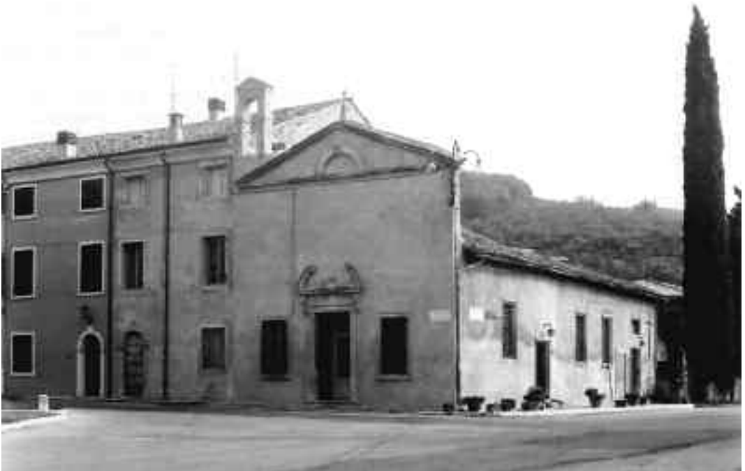
fig. 3. L'ex oratorio di S. Rocco, prima dei lavori di ristrutturazione (da VIVIANI 1991, p. 51).
