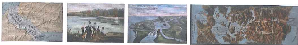
Fig. 4- Immagini storiche, risalenti all'inizio del secolo, relative alla costruzione del canale.
