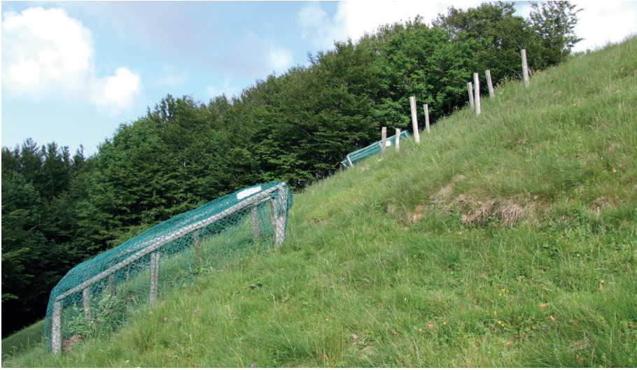
Fig. 16 Chiudende a salvaguardia della stazione di Trollius europaeus L. di Poggio Scali
