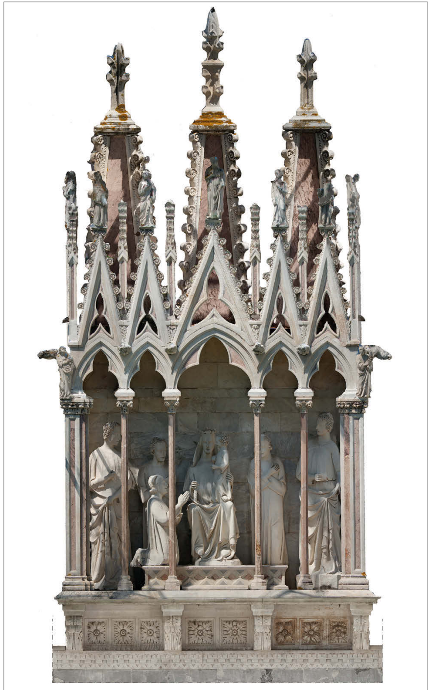
fig. 6 – Pisa. Camposanto. Fotopiano del Baldacchino dell'edicola che posta sopra la porta d'ingresso ottenuto con fotomodellazione SfM (elaborazione grafica degli autori).
