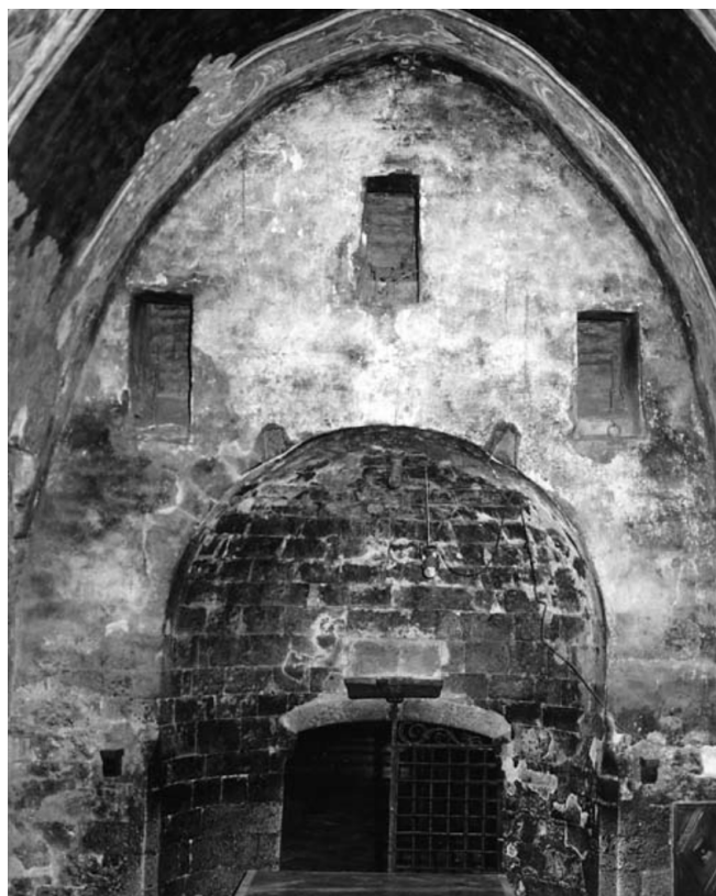
Fig. 9.54 Assisi, Porziuncola. Abside in pietra visibile in seguito alla rimozione della pala d'altare.
