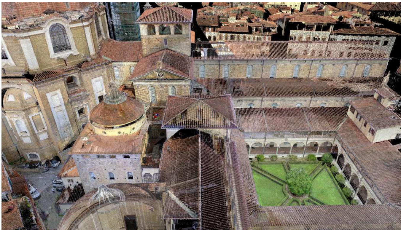
FIG. 5.2 Vista della nuvola di punti colorata e opportunamente trattata degli spazi esterni del complesso di San Lorenzo.
