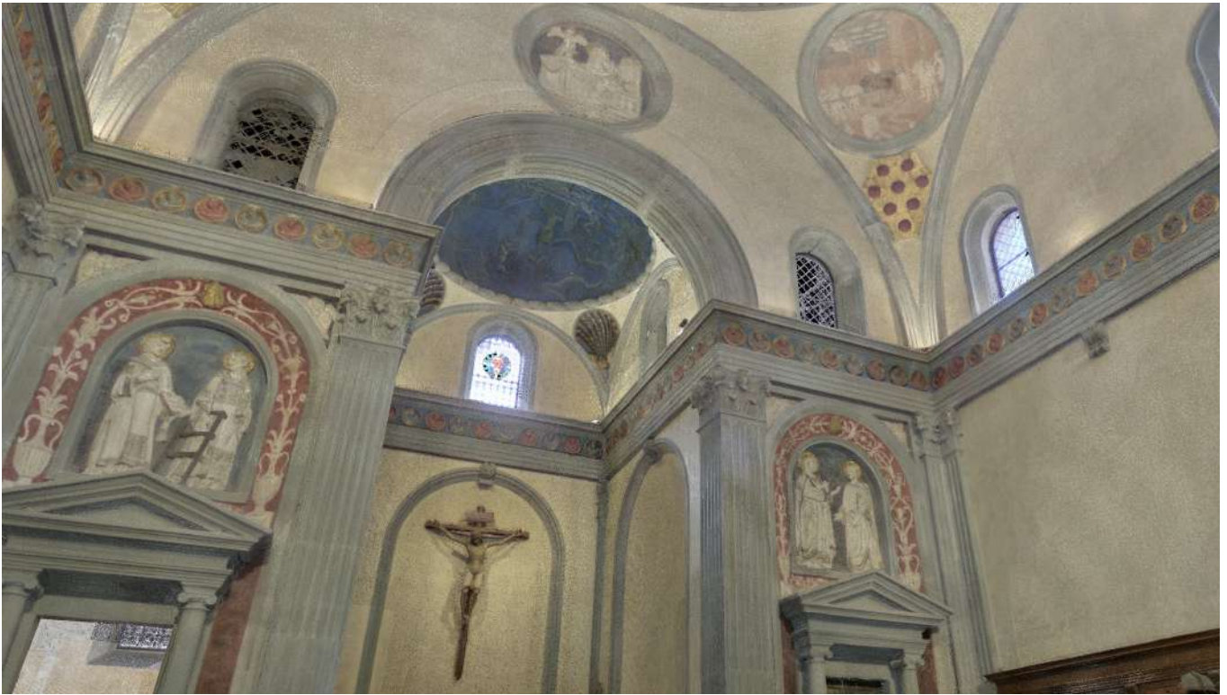
FIG. 5.3 Vista della nuvola di punti colorata e opportunamente trattata degli spazi interni della Sagrestia Vecchia.
