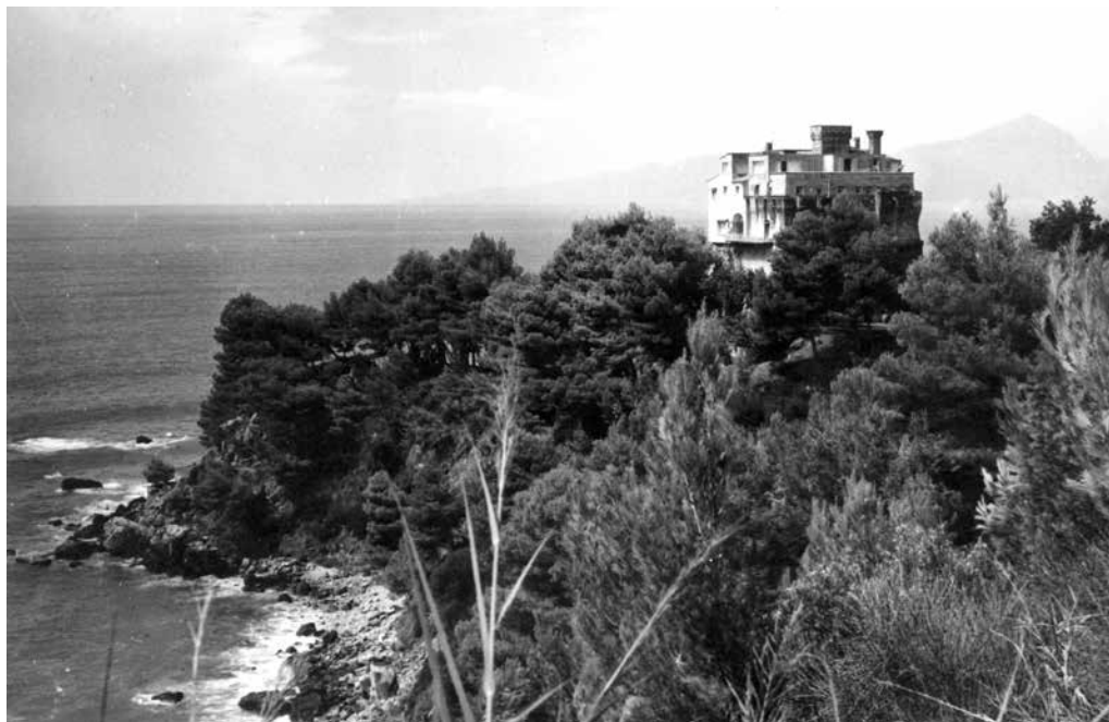
13. Torre Santavenere, veduta. ASF, Pier Niccolò Berardi, Stampe , 15
