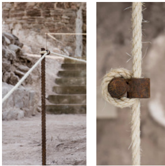
Parapetto percorsi esterni
