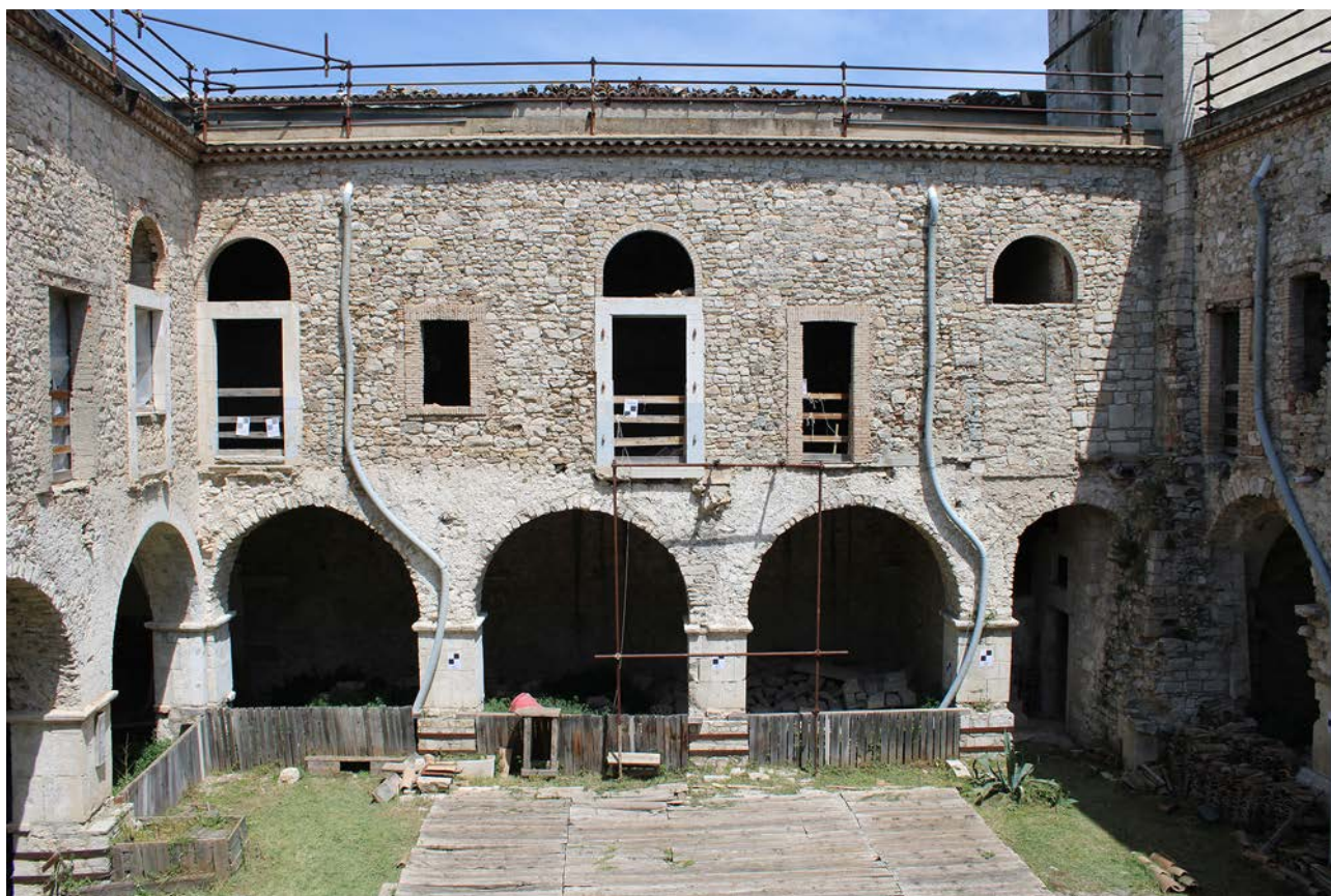
Fig. 3. Venosa (PZ), complesso di San Domenico, prospetto sud-ovest del chiostro, stato attuale (foto M. Parente 2022).
