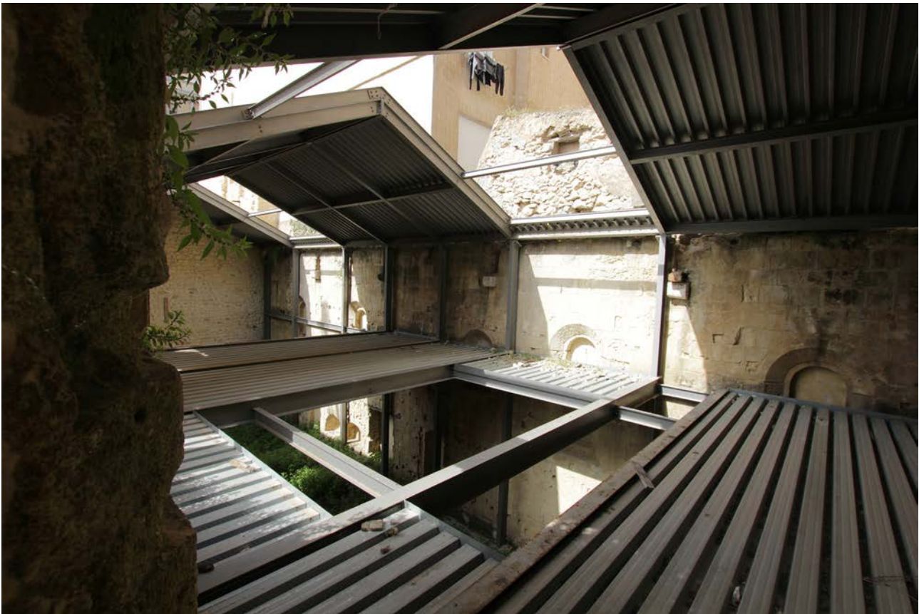
Fig. 4. Cagliari, convento di San Francesco, immagine di cantiere relativa all'inserimento del nuovo volume all'interno degli spazi storici del refettorio (foto M. Faiferri 2022).
