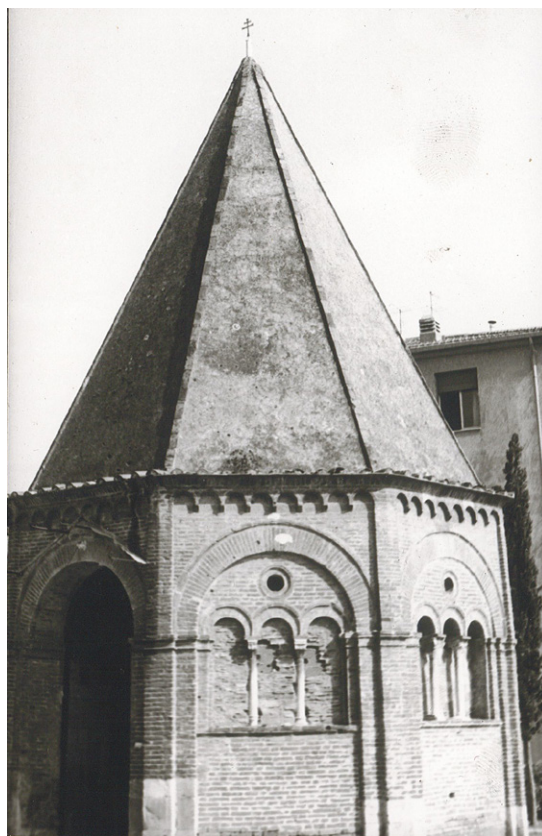
Fig. 4. Pisa, Cappella di Sant’Agata, 1964. Archivio di Restauro dei Monumenti, Caratteri , C 31/64 (Foto P. Benelli, G. Bofanti 1964).
