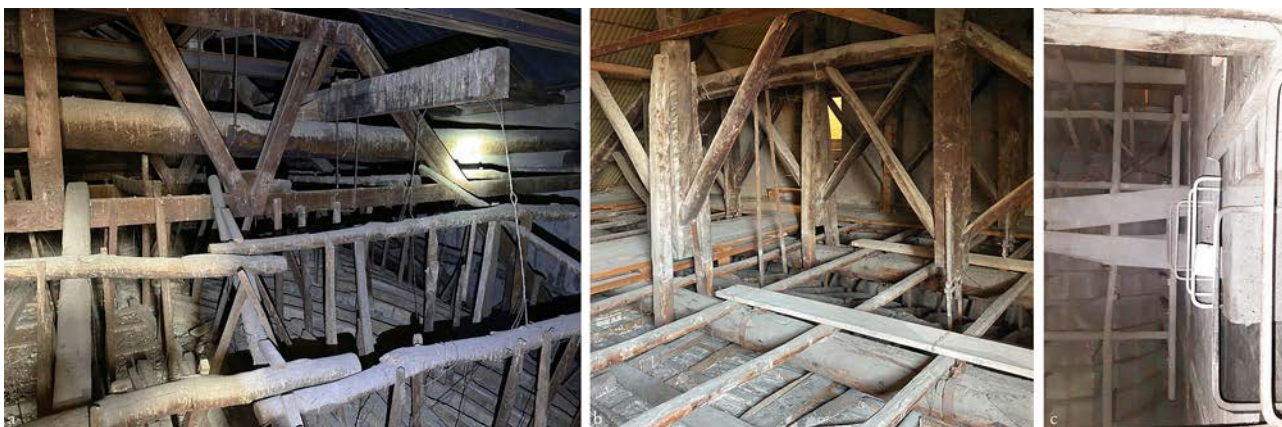
Fig. 1. a) Napoli, chiesa di Santa Maria Egiziaca all'Olmo, estradosso della volta a incannucciato; b) Napoli, chiesa di Santa Maria Regina Coeli, estradosso della volta a incannucciato del coro; c) Napoli, Palazzo Reale, estradosso della volta a incannucciato a copertura di un ambiente situato al secondo livello ammezzato. In tutti e tre i casi sono ben visibili le strutture di sostegno delle volte, autonome rispetto alla copertura/solaio (foto L. Romano 2021).
