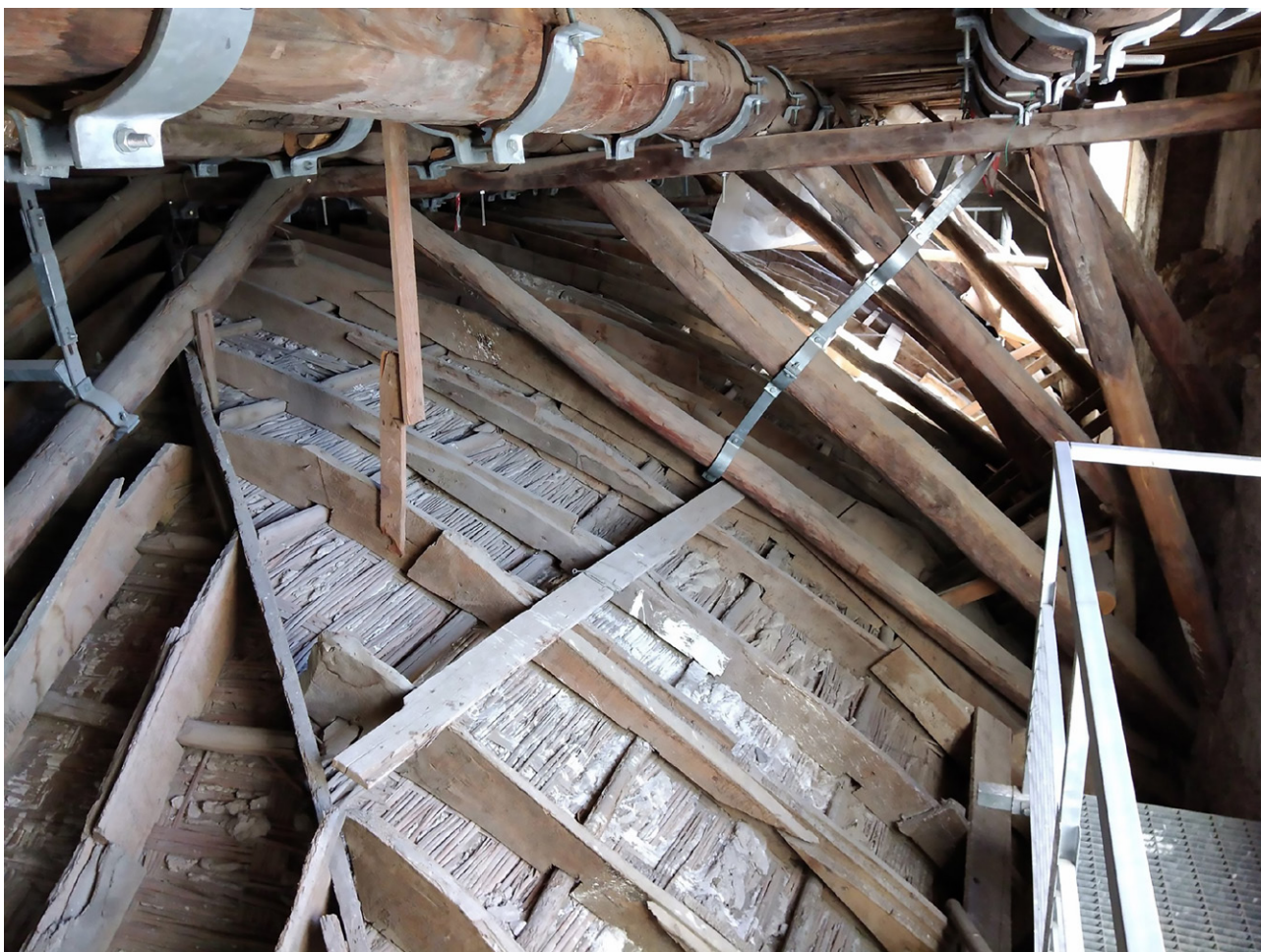
Fig. 2. Napoli, Palazzo Reale, estradosso della volta a incannucciato della Sala Diplomatica. La foto mostra i connettori e le cravatte metalliche di consolidamento a sostegno della volta (foto S. Gei 2020).
