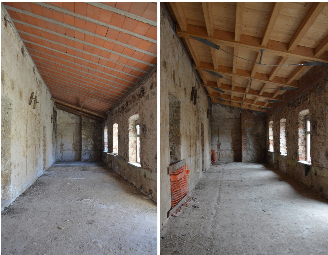
Fig. 5. Oristano, convento di San Francesco, prima e dopo l'intervento di demolizione e ricostruzione delle coperture (foto E. Pilia 2019/2021).
