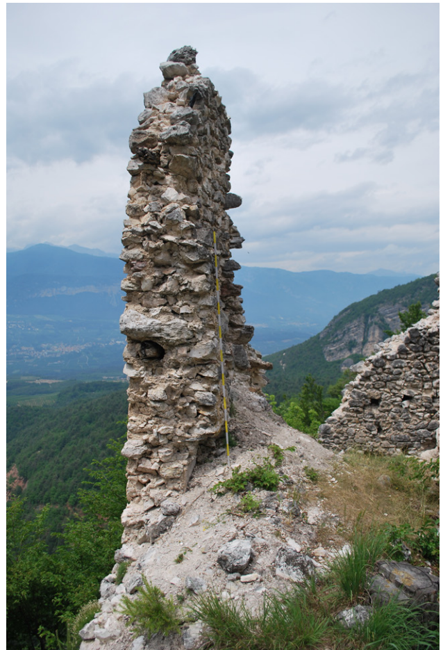
Fig. 4. Vigo di Ton (TN), castel S. Pietro, lo studio della qualità costruttiva e dei rapporti tra le parti consentono di individuare tecniche locali ad alta efficacia strutturale come i radiciamenti lignei presenti nella vela muraria e il loro sistema di connessione in corrispondenza di murature ortogonali e di sistemi voltati interni (foto I. Zamboni 2022).
