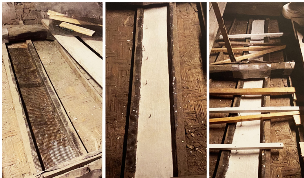
Fig. 4. Firenze, chiesa di San Carlo de' Barnabiti, stesura delle fibre di basalto, della polpa di cellulosa additivata con resina acrilica e ancoraggio alle centine in legno (da CONTI, FIORINI, MASTRODICASA 2022, p. 71).
