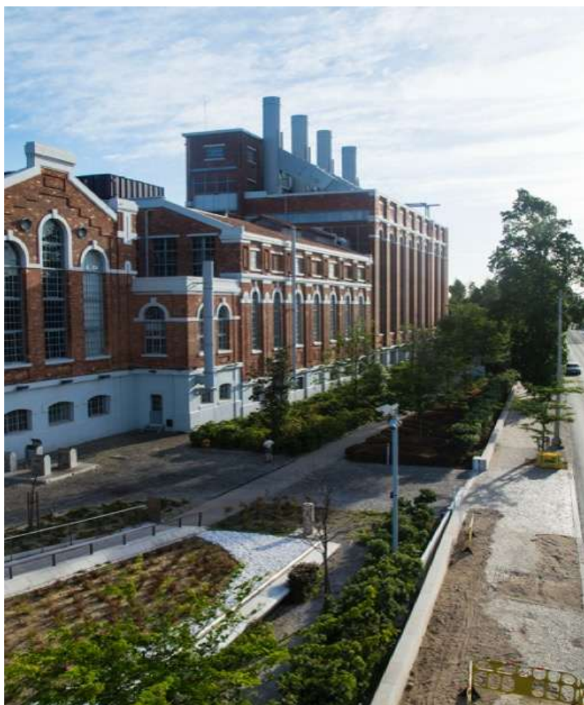
3: Central Tejo, 2023 [immagine propria]. L'immagine mostra il lato nord dell'edificio, rivolto verso la città e costeggiato dalla strada e dalla ferrovia.
