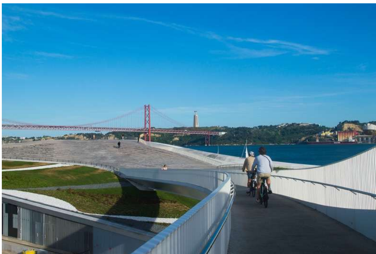
4: MAAT, 2023 [immagine propria]. L'immagine mostra l'arrivo del ponte pedonale sulla copertura del MAAT, in parte sistemata a giardino, come prosecuzione del giardino sul lato nord della centrale, in parte pavimentata ad estendere la passeggiata lungofiume sul lato sud del complesso museale.
