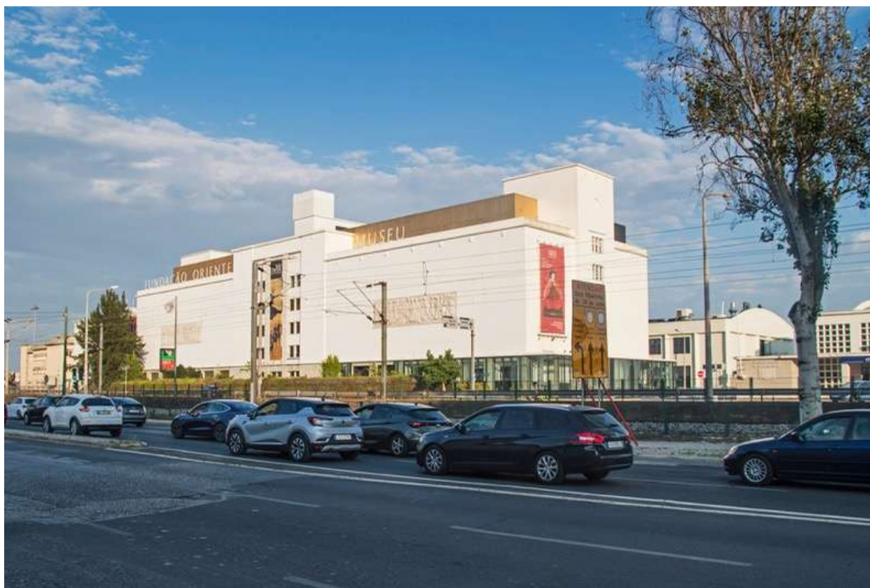
2: Museo della fondazione Oriente, 2023 [immagine propria]. L'immagine evidenzia la percezione prevalente dell'edificio, un oggetto che attrae l'attenzione ma appare inaccessibile per via della strada a scorrimento veloce e della linea ferroviaria che lo separano dalla città.
