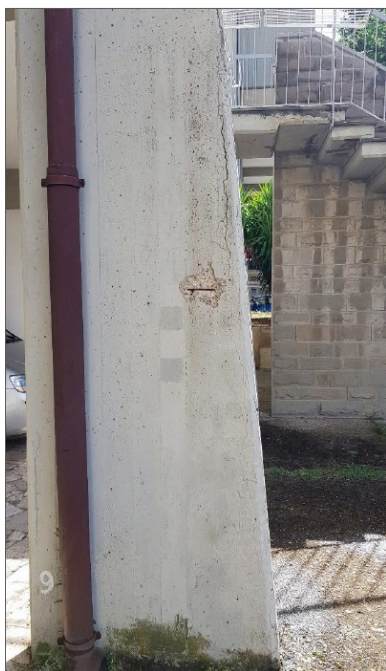
Figura Il problema degli interventi su edifici esistenti in cemento armato-11: Dettaglio segni di degrado su alcuni pilastri (Castellini M. 2024).
