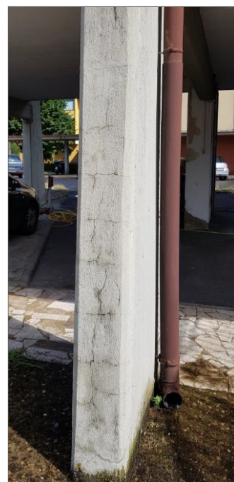
Figura Il problema degli interventi su edifici esistenti in cemento armato-11: Dettaglio segni di degrado su alcuni pilastri (Castellini M. 2024).
