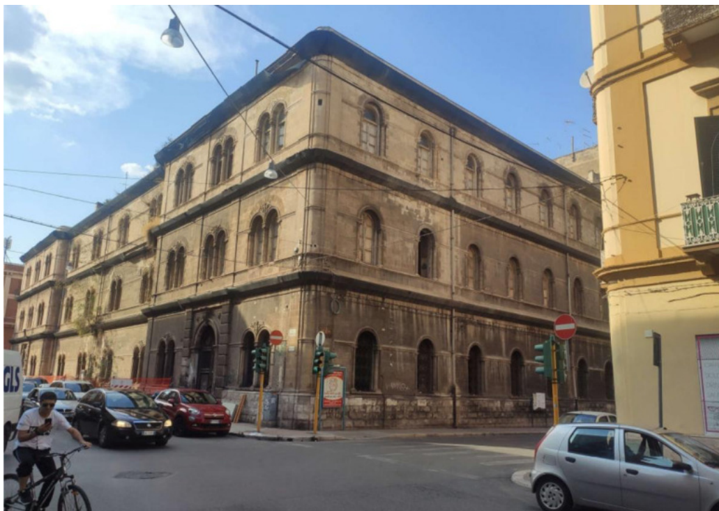
Fig. 1| Esterno di Palazzo Frisini, stato attuale.
