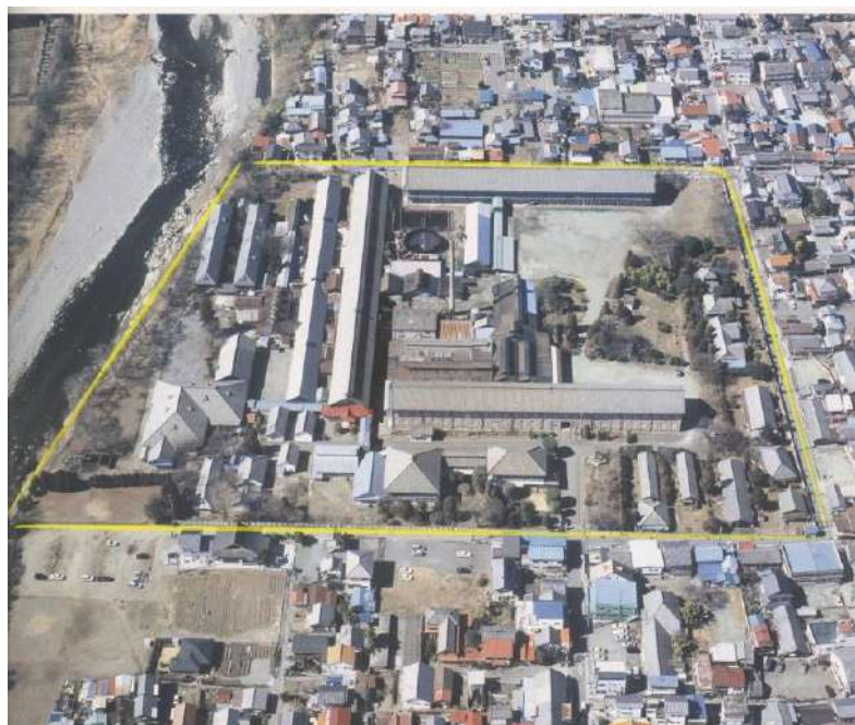
Fig. 2 – Filanda di Tomioka. L'impianto visto dall'alto.
