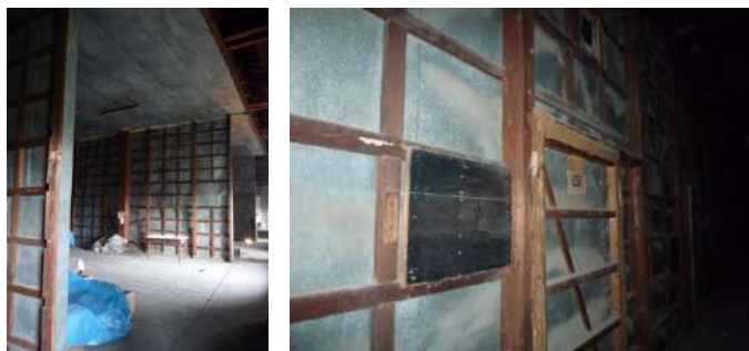
Fig. 28 – Camera con pareti in lamine zincate a chiusura ermetica risalente al 1900 circa.
