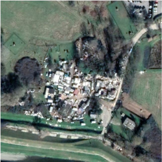
Figura 13 Il campo nomadi Rom in area di rischio idraulico (© estratti fotografici da Google Earth)
