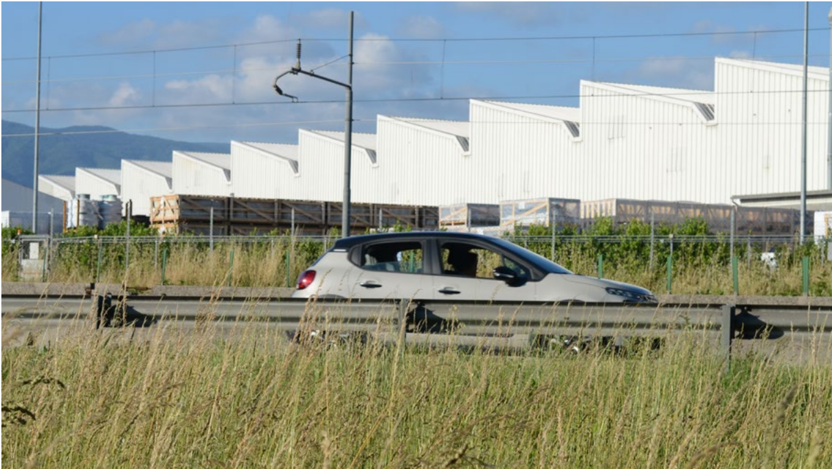
Figura 17 Il margine lungo la strada tangenziale nel tratto di minimo dislivello di fronte al complesso Hitachi (© UNIFI DIDA Landscape Design Lab, 2021)
