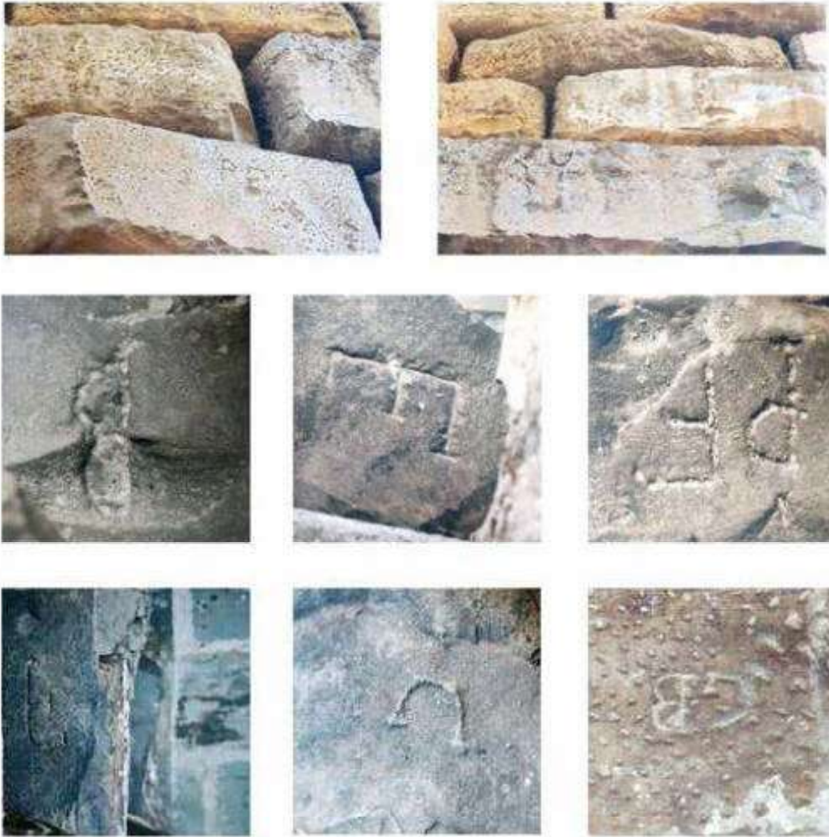
Fig. 113 - Rondò di Bacco; nella parte conclusiva realizzata dal Poccianti si osserva la presenza di contrassegni di lapicidi; (sopra) nei conci che affiancano la nicchia; (sotto) nel lato superiore e frontale dei conci del basamento. Rondò di Bacco; stonecutters' marks can be observed in the concluding part created by Poccianti: (above) in the ashlars flanking the niche; (below) in the upper and front side of the base ashlars.
