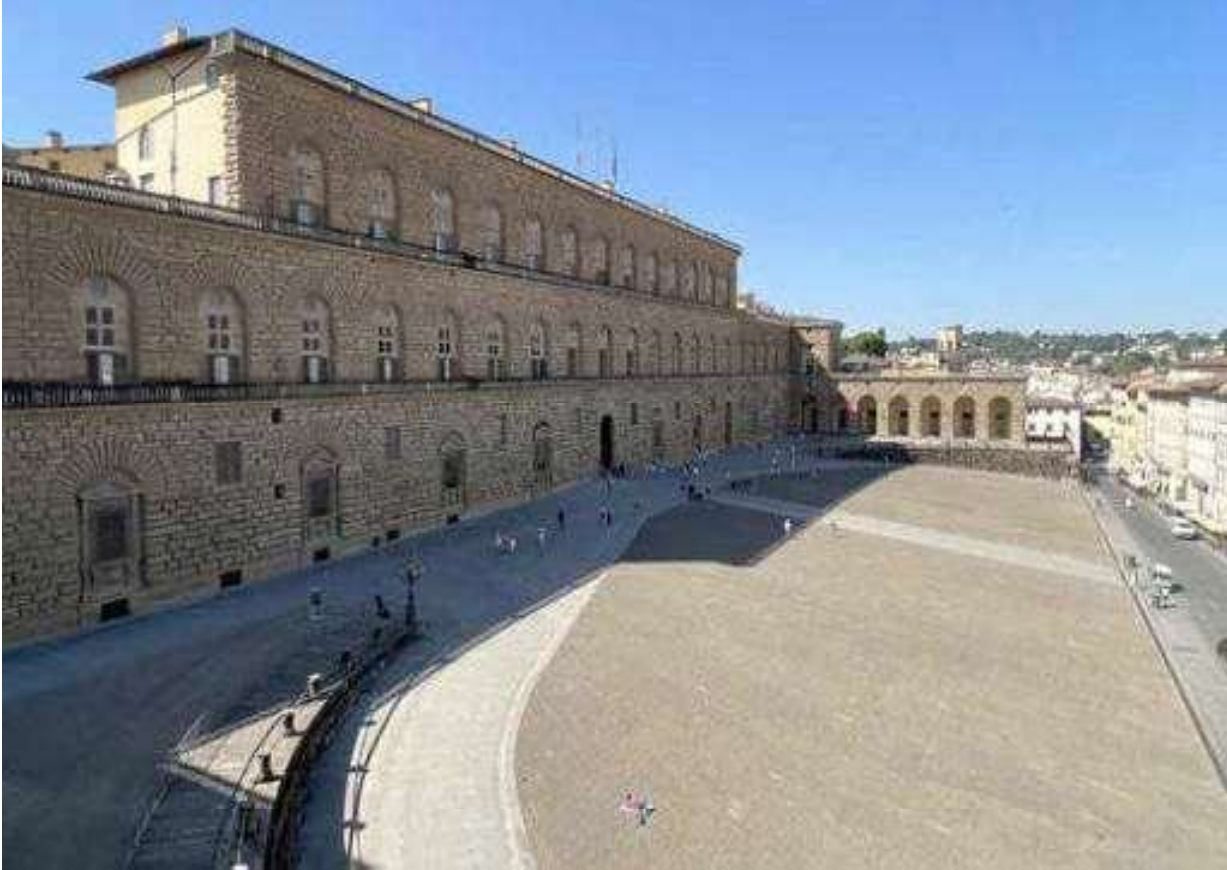
Fig. 6 - Firenze, piazza e palazzo Pitti con vista del rondò delle Carrozze (UNIFI, AFR). Florence, Piazza Pitti and the Pitti Palace with a view of the Rondò delle Carrozze.
