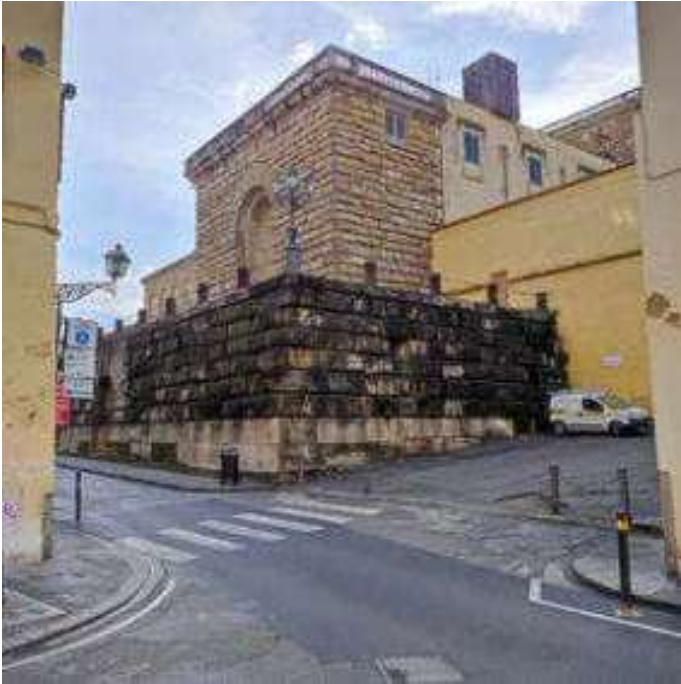
Fig. 104 - Testata dal lato esterno del rondò delle Carrozze (UNIFI, AFR). End on the outer side of the Rondò delle Carrozze.
