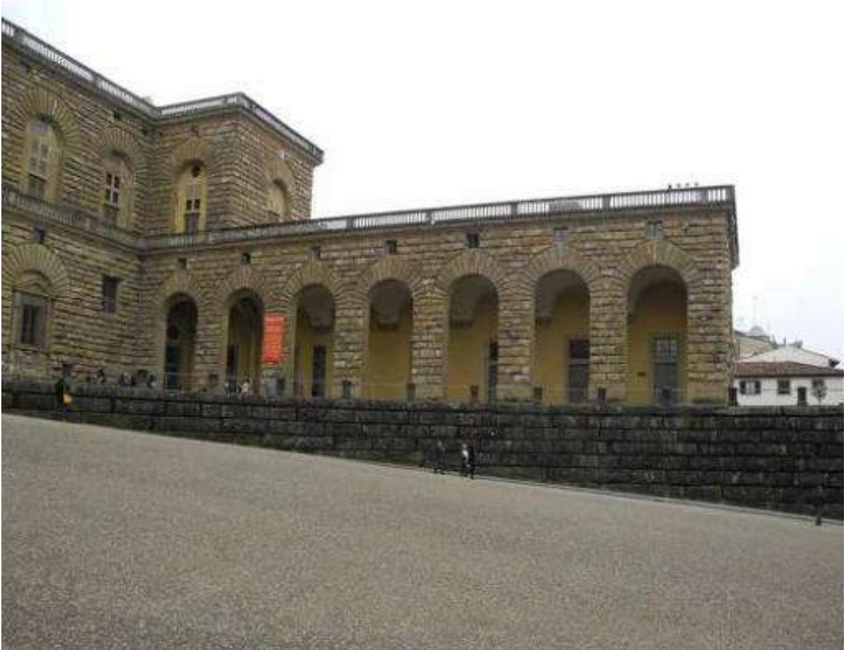
Fig. 28 - Palazzo Pitti, rondò delle Carrozze (UNIFI, AFR). Pitti Palace, Rondò delle Carrozze.
