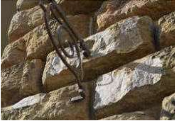
Fig. 51 - Rondò delle Carrozze; particolari del bugnato (UMFI, AFR). Rondò delle Carrozze; details of the rustication.
