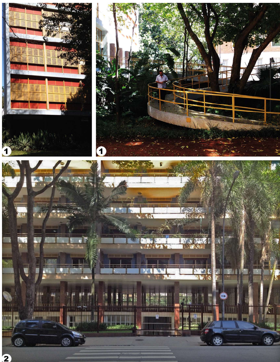
Figura 2: 1. Edifício Louveira – J. B. Vilanova Artigas e C. Cascaldi. 2. Edifício Prudência – R. Levi. Foto degli autori, 2017.
