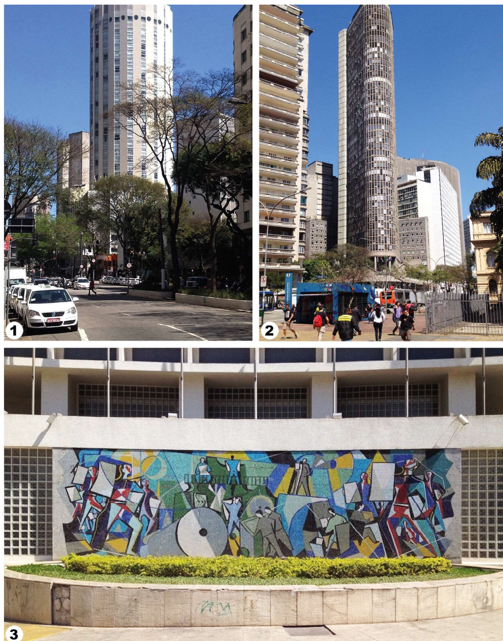
Figura 5: 1. Hilton Hotel – E. Siffredi e M. Bardelli. 2–3. Edifício Itália e O Estado de São Paulo – F. Heep. Foto degli autori, 2017.
