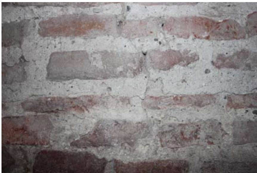
Fig. 12 – S. Nazaro, tecnica costruttiva a corsi orizzontali di laterizi nell'esedra destra del braccio meridionale (fine del IV sec. d.C.)
