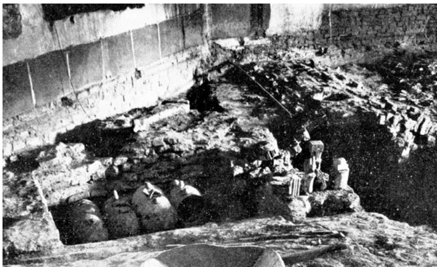
Fig. 14 – S. Aquilino, estradosso della volta con materiale anforaceo (Archivio fotografico della Soprintendenza per i Beni archeologici della Lombardia)
