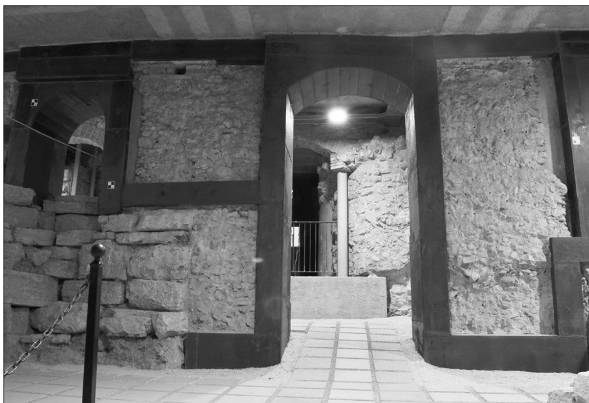
20. FONDAZIONI DEI PILASTRI DEL LOGGIATO ADIACENTE ALL'ABSIDE DELLA CATTEDRALE PORTATE IN LUCE DAGLI SCAVI, CON LE STRUTTURE METALLICHE DI RINFORZO CHE SI SONO POI RESE NECESSARIE (foto Autori)
