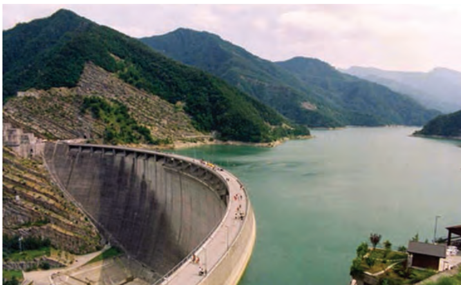
Fig. 25. Diga di Ridracoli (fonte: http://www.ervet.it/wp-content/uploads/2013/09/Rapporto_infrastrutture_verdi_2015.pdf ; ultima visita: Maggio 2023)
