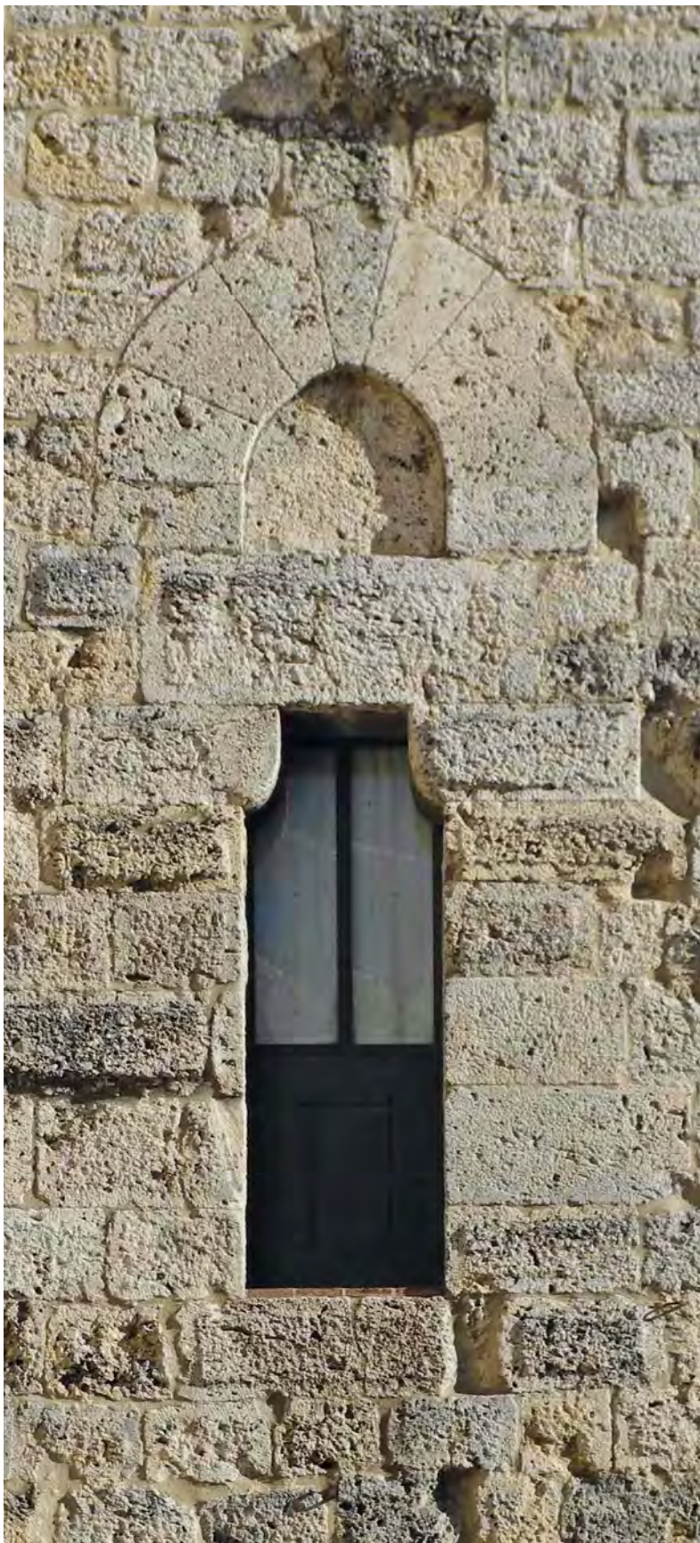
Originaria porta della torre aperta sul fronte occidentale. Original door of the tower opened on the west face.
