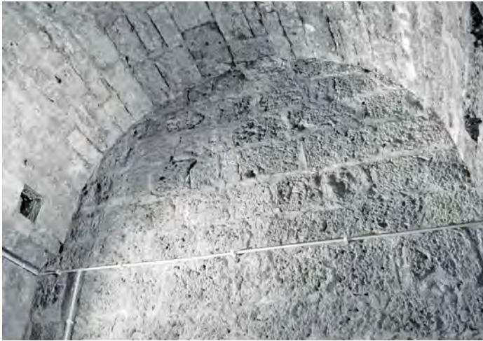
Volta a botte alla sommità della torre, con all'imposta i fori per sostegno di centine di costruzione (a sinistra) e panorama delle colline circostanti dal ballatoio sommitale (a destra). Barrel vault at the summit of the tower with the holes to support construction centring at the springer of the vault (left) and view of the surrounding hills from the summit balcony (right).
