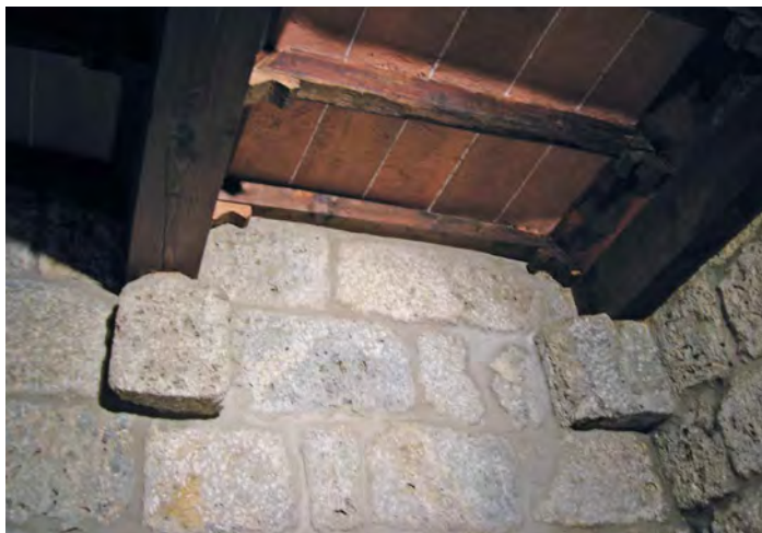
Mensole lapidee di sostegno dei solai lignei al terzo (a sinistra) e all'ottavo livello (a destra). Stone corbels supporting the wooden floors on the third (left) and on the eighth level (right).
