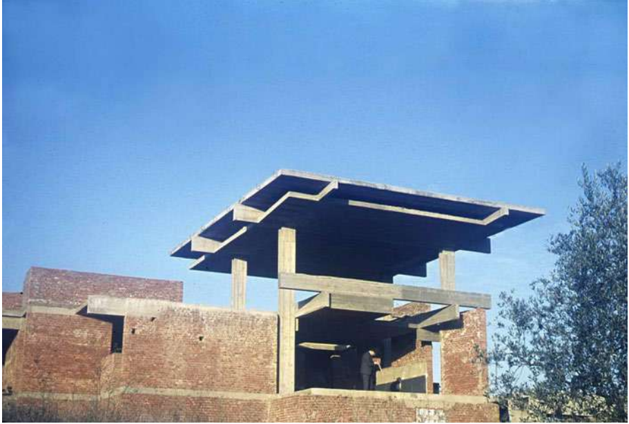
Fig.3_ Foto di cantiere, Kodachrome 35 mm
