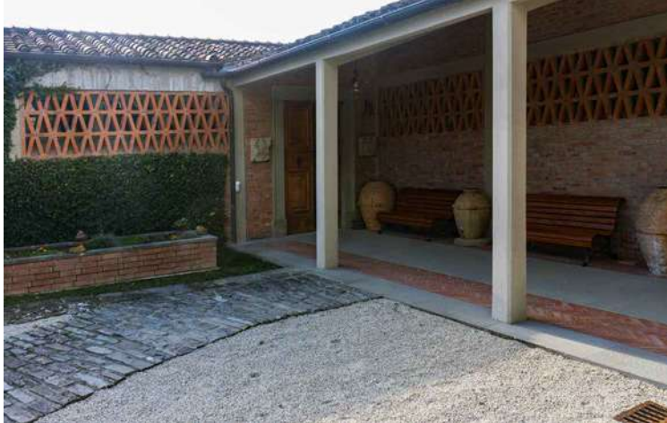
Fig.2_ Vialetto e porticato d'ingresso
