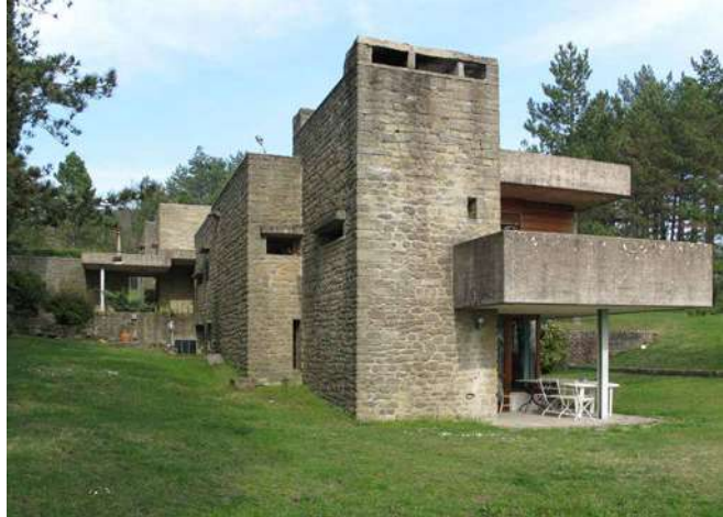
Fig.5_ Fronte a nord
