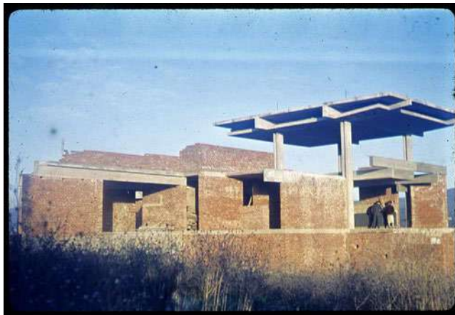
Fig.4_ Foto di cantiere
