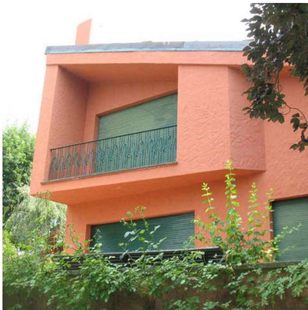
Fig. 10_ Dettaglio di una facciata. S.d.
