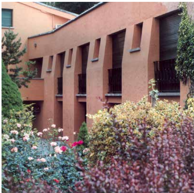
Fig. 11_ Dettaglio di una facciata. S.d.
