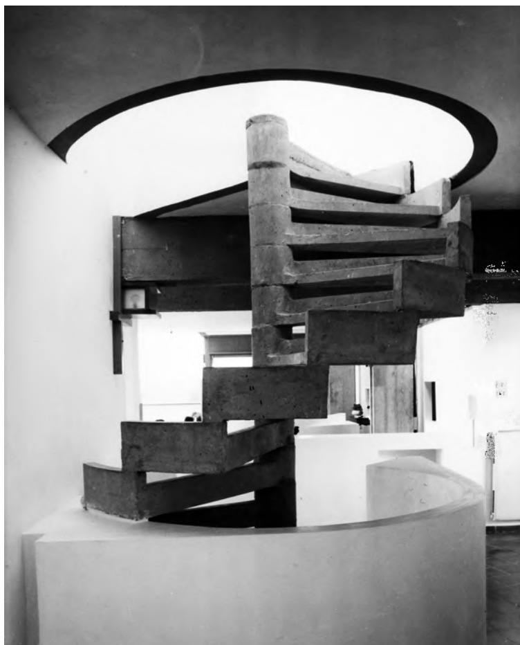
Fig. 11_ Foto della scala chiocciola prefabbricata, stampa b/n
