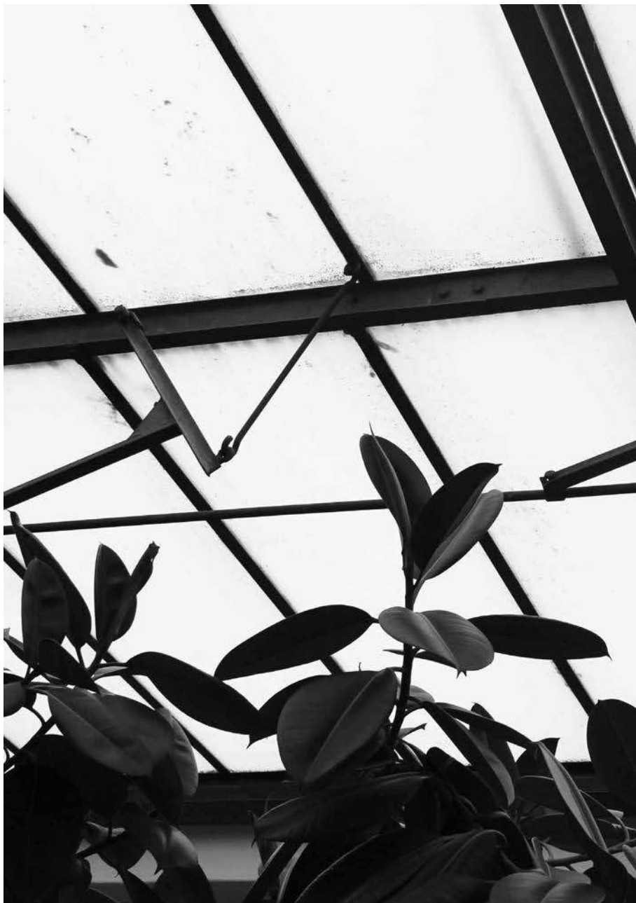
Fig.3_ Villa Longinotti Buitoni, Serra (dettaglio)
