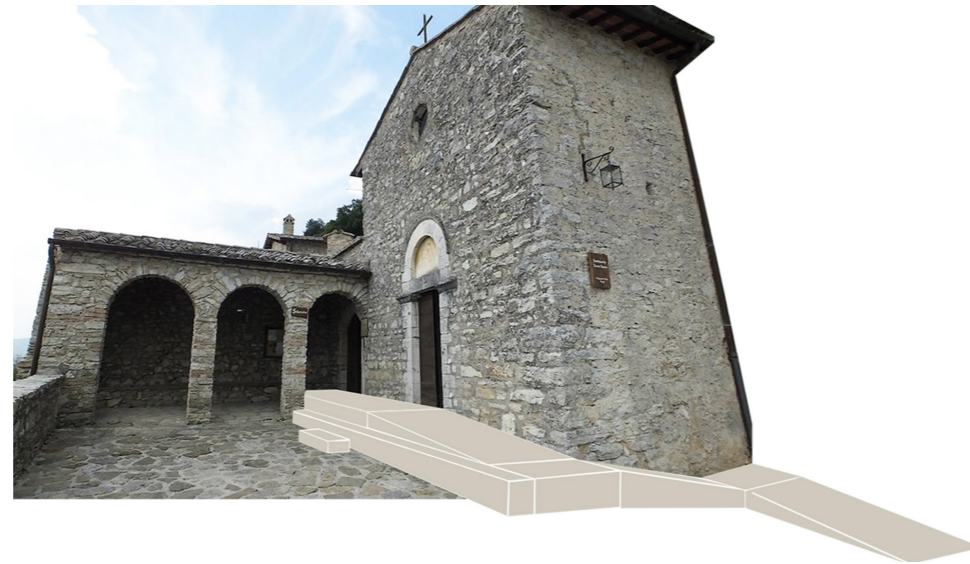
Fig. 21-23: Elaborati grafici relativi ai complessi conventuali dell'Eremo delle Carceri (PG) e dello Speco di Narni (TR) — analisi delle criticità di accesso e proposte progettuali per soluzioni non invasive per l'accessibilità.
