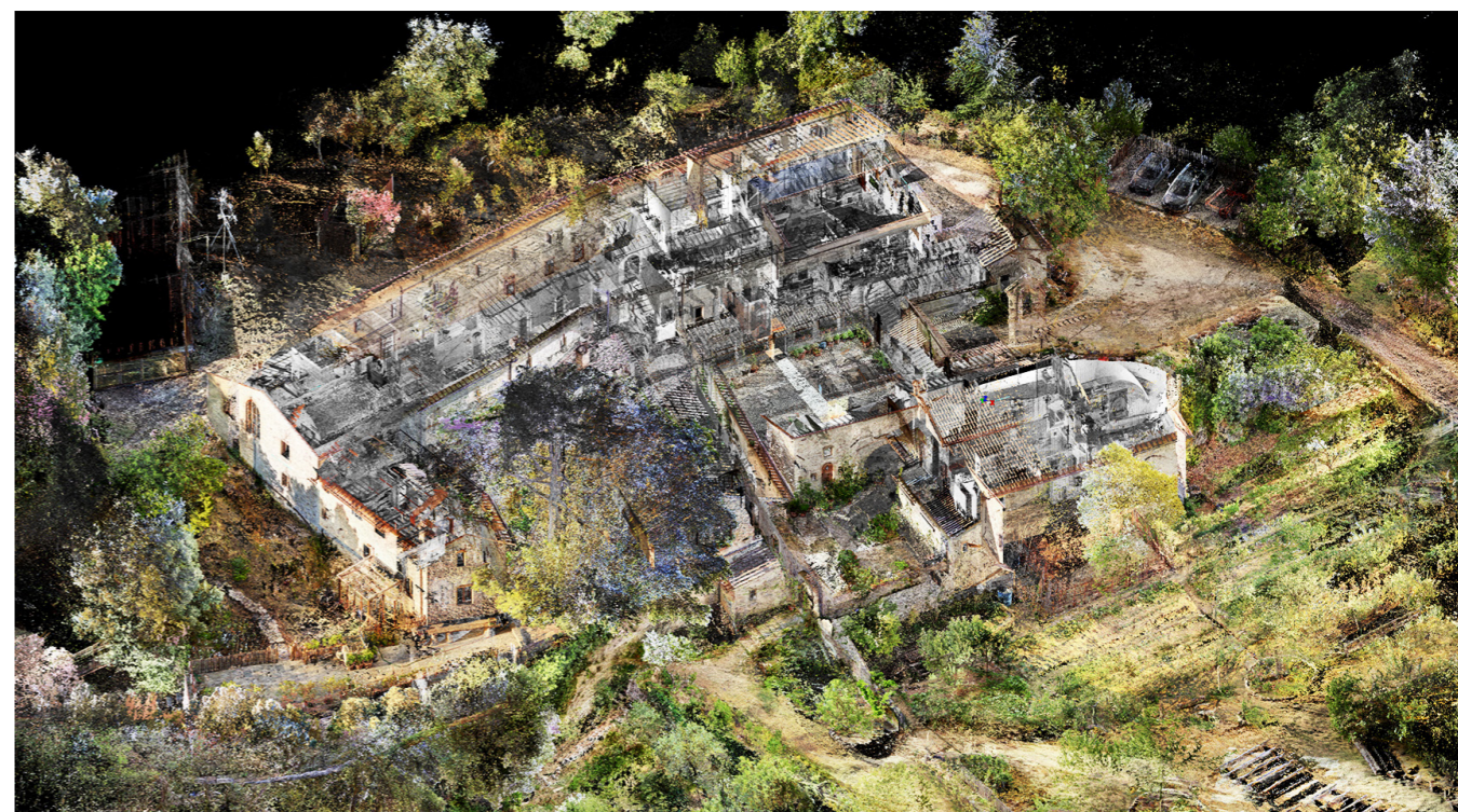
Fig. 7: Rilievo digitale laser-scanner della Romita di Cesi (TR), con indicazione della posizione delle singole scansioni e visualizzazione della nuvola di punti.
