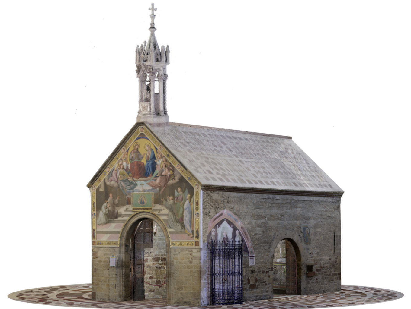
Fig. 2: Nuvola di punti della Porziuncola in Santa Maria degli Angeli (PG).
