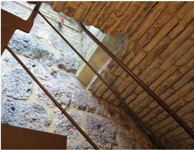
Volta laterizia dell'ultimo livello. Brick vault of the top level.
