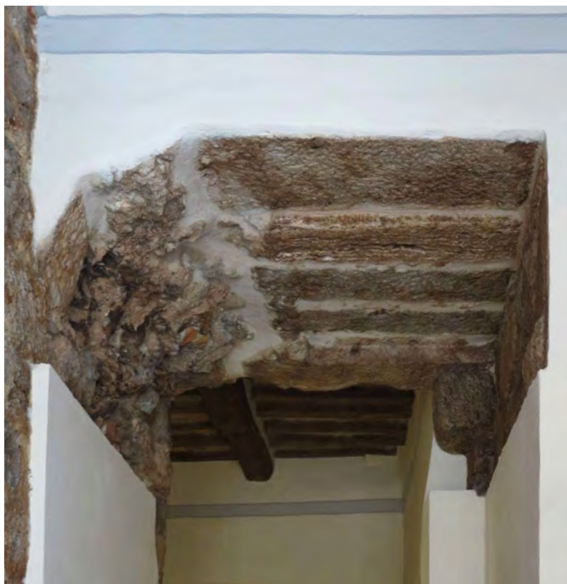
Al primo livello nel muro occidentale della torre è stato realizzato un ampio varco demolendo una delle spallette della preesistente apertura. Sono visibili le lunghe pietre che ne costituivano l'architrave e il nucleo interno del muro lasciato alla vista dopo la demolizione. At the first level in the west wall of the tower a large opening was created by demolishing one of the jambs of the pre-existing opening. The long stones that made up the lintel and the inner core of the wall left exposed after the demolition are visible.
