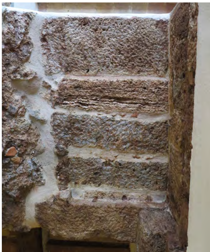
Al primo livello nel muro occidentale della torre è stato realizzato un ampio varco demolendo una delle spallette della preesistente apertura. Sono visibili le lunghe pietre che ne costituivano l'architrave e il nucleo interno del muro lasciato alla vista dopo la demolizione. At the first level in the west wall of the tower a large opening was created by demolishing one of the jambs of the pre-existing opening. The long stones that made up the lintel and the inner core of the wall left exposed after the demolition are visible.
