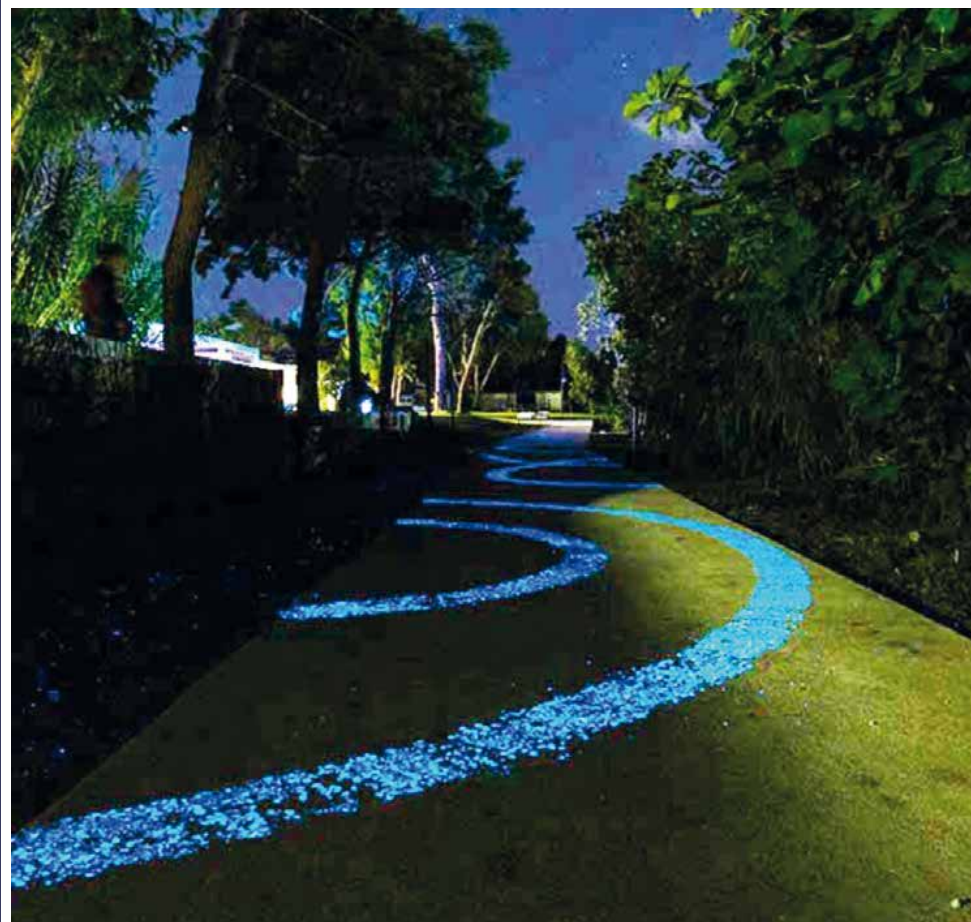
pavimentazione con inserti in ghiaia fotoluminescente
