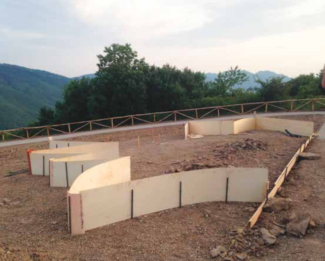
Preparazione della cassaforma per la realizzazione del sole / Preparation of the shuttering for the realization of the sun (© Marco Cei)
