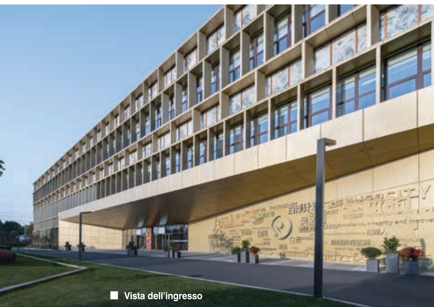
■ Vista del sistema di facciata sul cortile centrale
