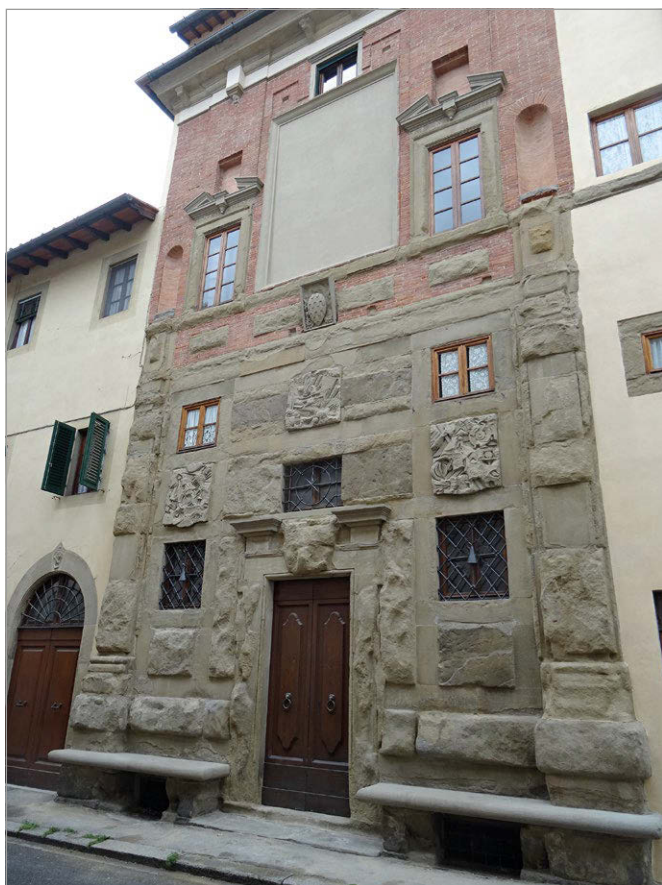
Fig. 8 – Firenze, palazzo Zuccari. La facciata dopo il restauro (foto Direzione lavori).
